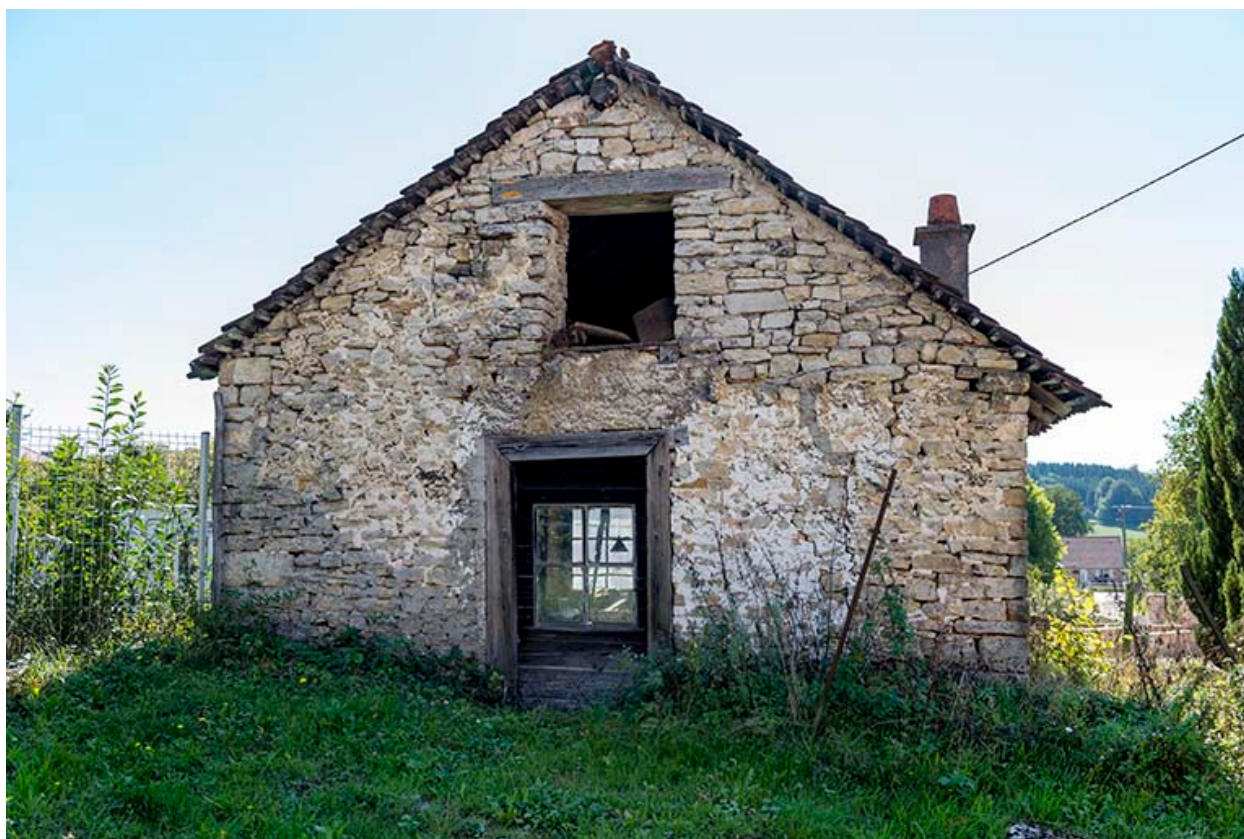
Forge : façade antérieure.
