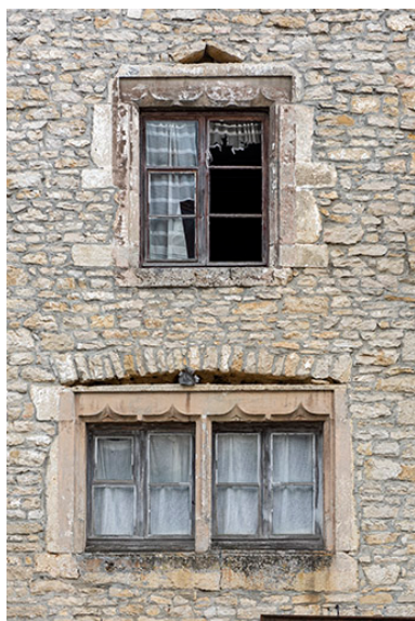
Maison, façade antérieure : fenêtres à meneau et arcs en accolade. Phot. Sonia Dourlot IVR43_20192501261NUC4A
