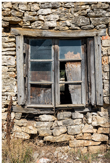
Forge, façade postérieure : fenêtre. Phot. Sonia Dourlot
