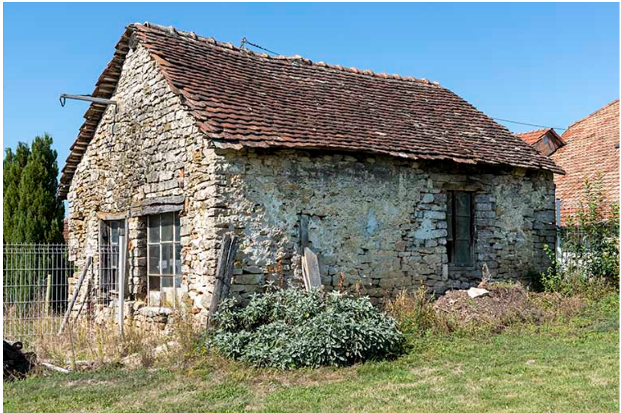
Forge : façades postérieure et latérale gauche.
