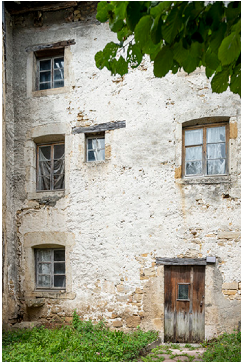
Maison : façade postérieure, de trois quarts.
