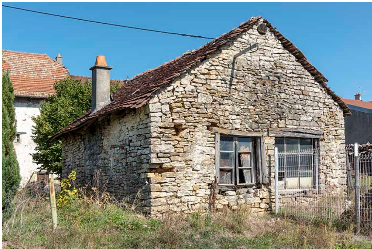
Forge : façade postérieure, de trois quarts gauche.
