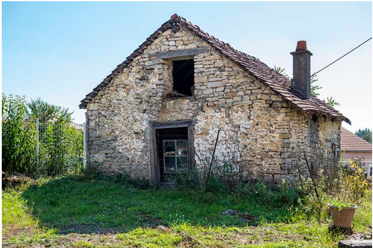
Forge : façade antérieure, de trois quarts droite.
