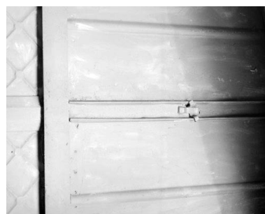
Système d'agrafage d'un panneau métallique (façade latérale droite). Phot. Yves Sancey IVR43_19943901594X
