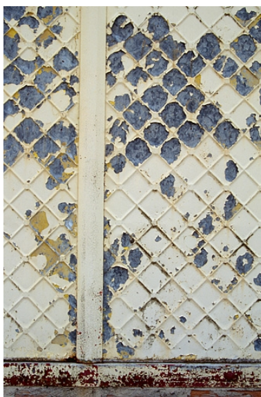
Détail d'un panneau métallique (façade latérale gauche). Phot. Yves Sancey IVR43_19943901593ZA
