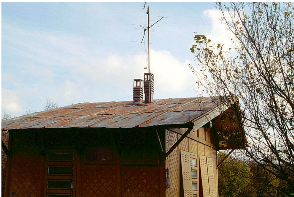
Toiture et cheminées.
