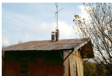
Toiture et cheminées. Phot. Yves Sancey IVR43_19943901591ZA
