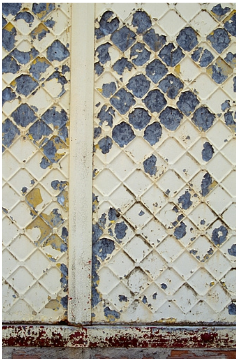
Détail d'un panneau métallique (façade latérale gauche).
