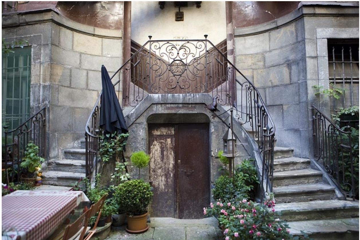
Détail de l'entrée de cave.
