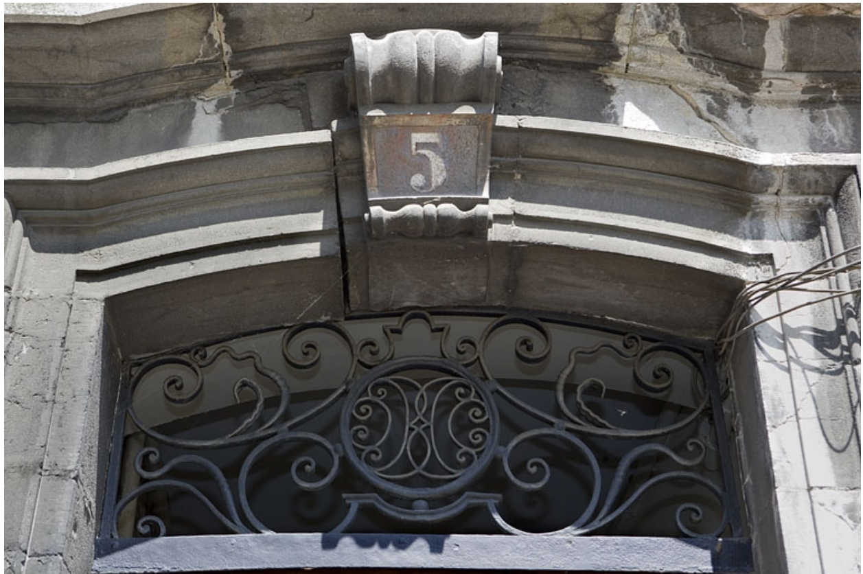
Détail de l'imposte en ferronnerie de la porte du couloir.
