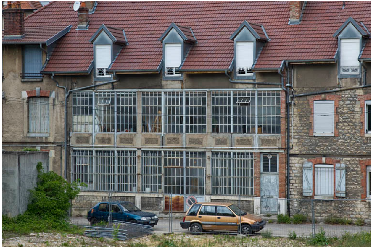
Façade postérieure de l'atelier de fabrication.
