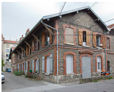
Distillerie : bâtiment sur la ruelle, vu depuis le sud.
