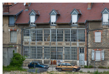
Façade postérieure de l'atelier de fabrication.
