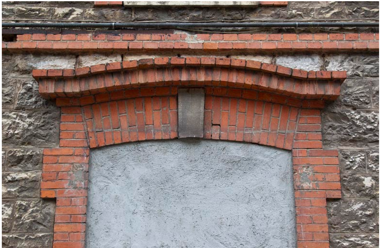
Détail d'une ouverture murée de la distillerie.
