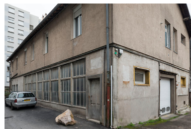
Atelier de fabrication. Phot. Jérôme Mongreville IVR43_20172501390NUC4A
