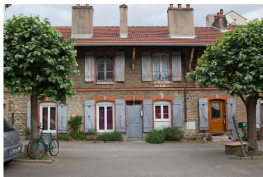
Façade antérieure de la distillerie. Travée des logements (et bureaux ?). Phot. Yves Sancey IVR43_20112502336NUC2A
