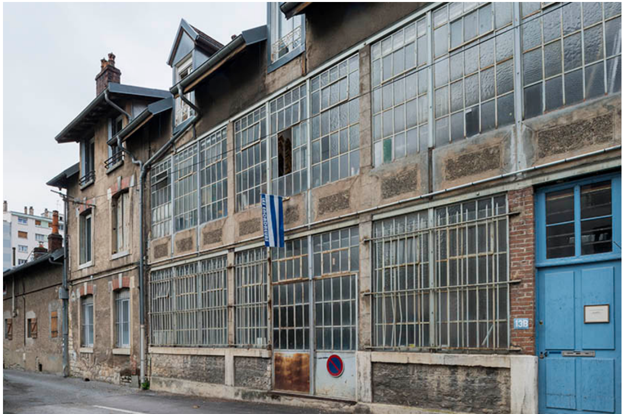
Façades d'ateliers ruelle de la Mouillère.
