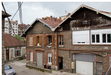
Pignons ouest de la distillerie.
