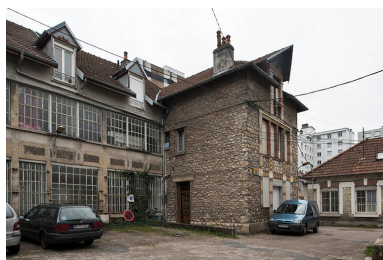
Bâtiments industriels vus depuis la cour. Phot. Jérôme Mongreville IVR43_20172501397NUC4A
