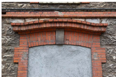
Détail d'une ouverture murée de la distillerie.
