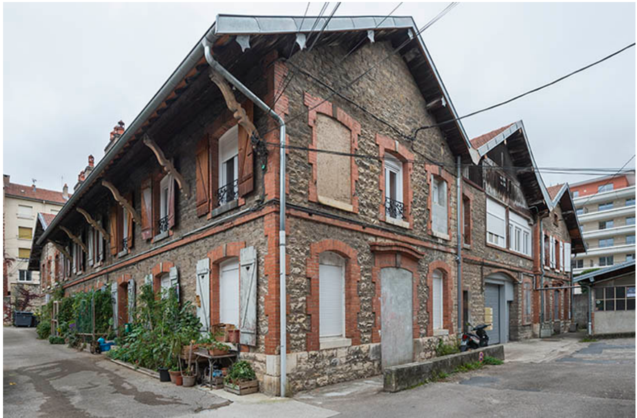
Bâtiment de la distillerie, depuis le sud.
