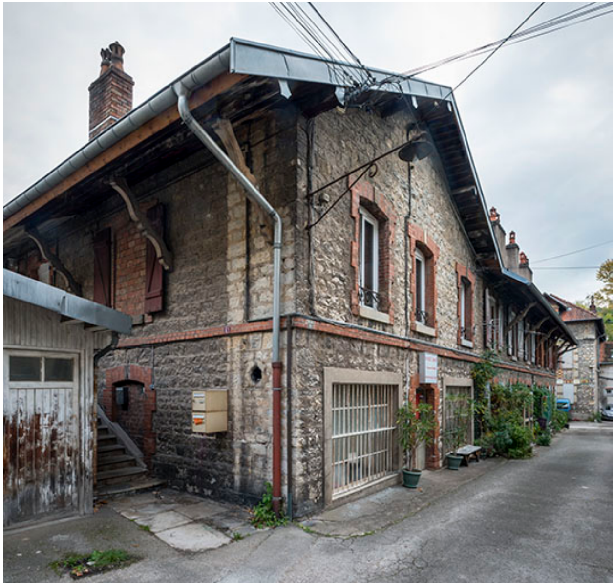
Pignon et façade sud de la distillerie.
