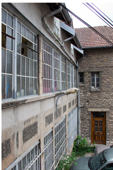
Façade d'un atelier de fabrication. Vue en enfilade.
