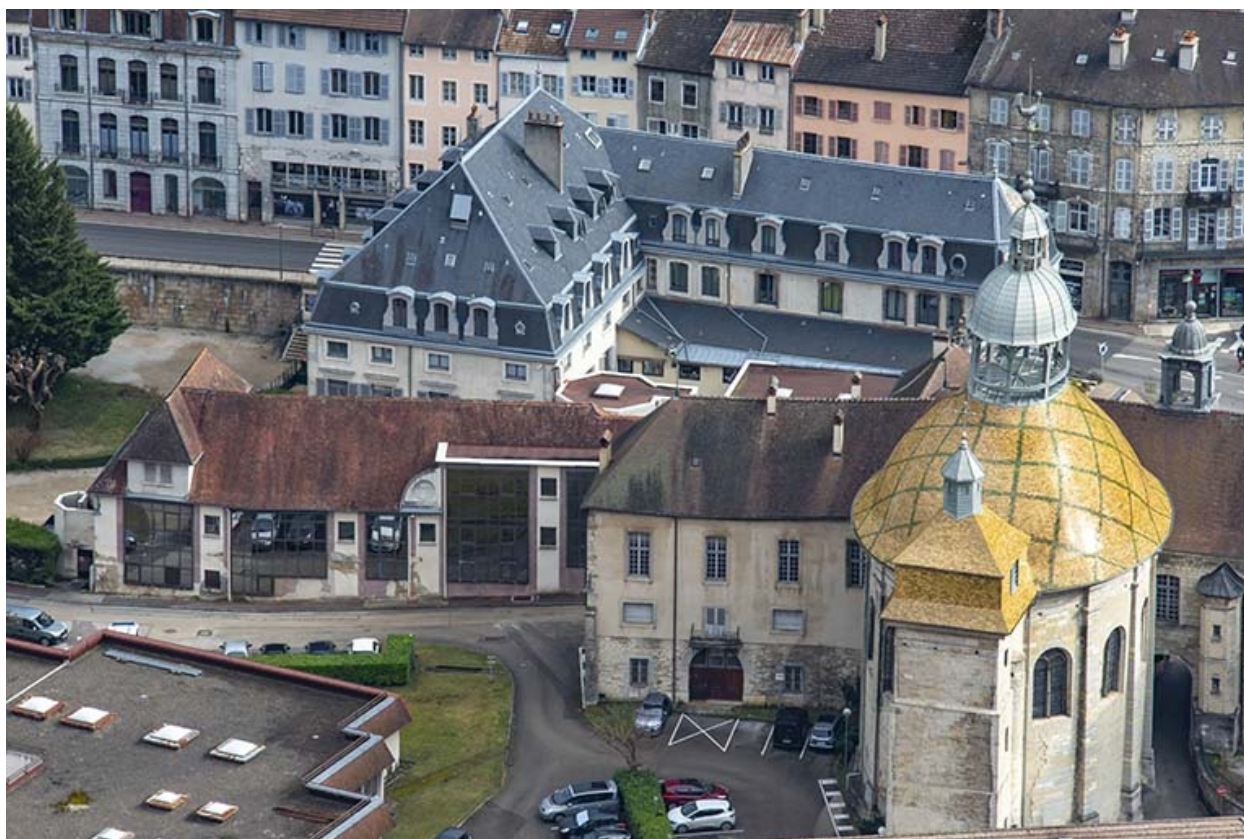
Vue depuis l'ouest.
