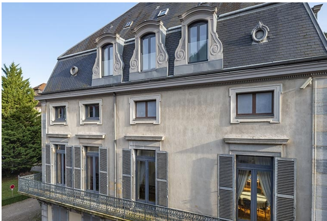
Façade ouest, détail.
