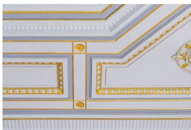
Salle de restaurant, plafond, détail. Phot. Jérôme Mongreville IVR43_20213900254NUC4A
