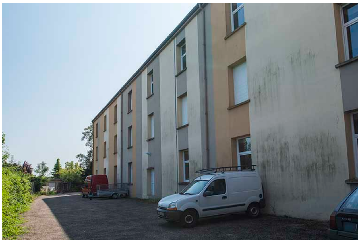
Façade nord de la barre d'externat nord.
