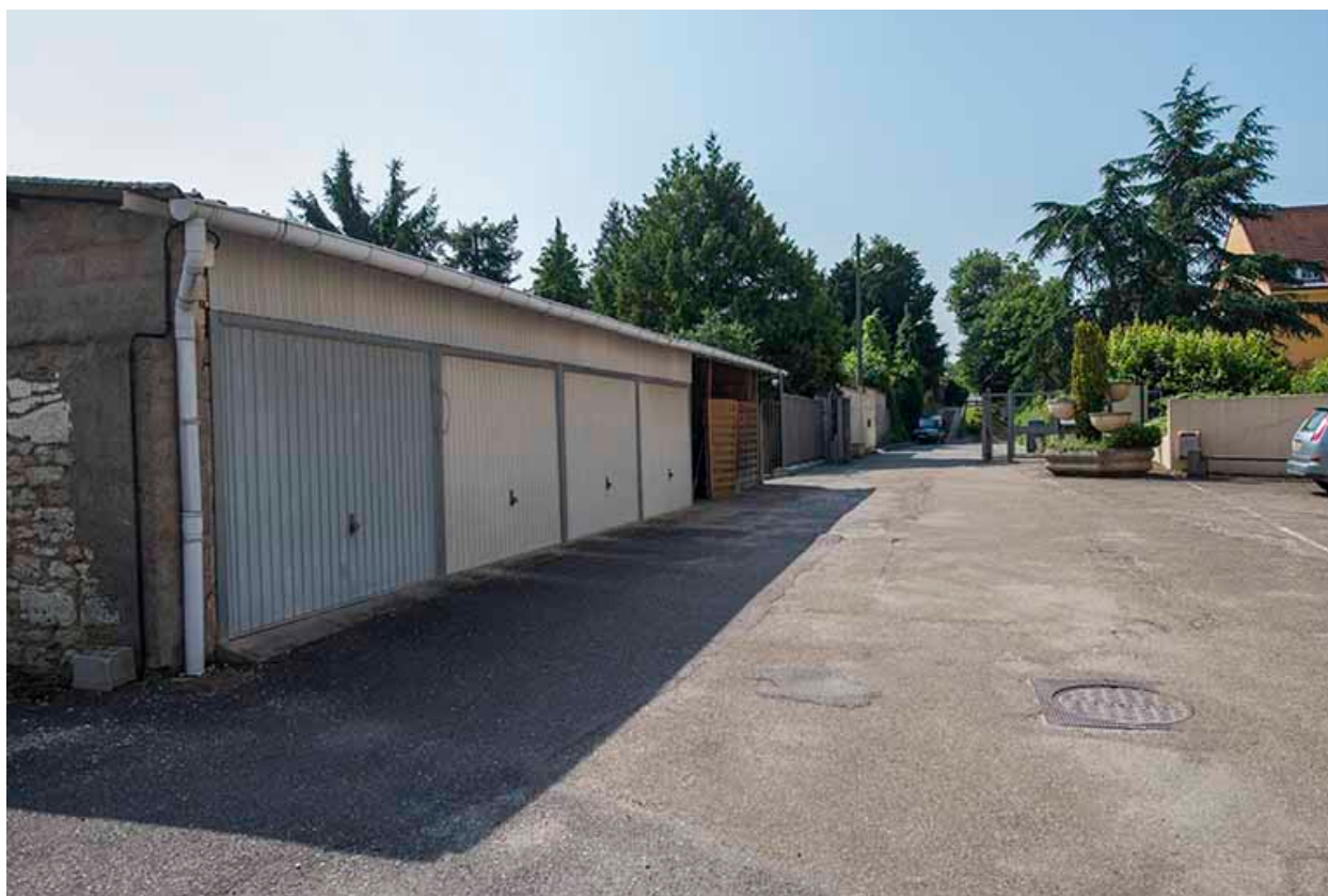
Entrée et garages.
