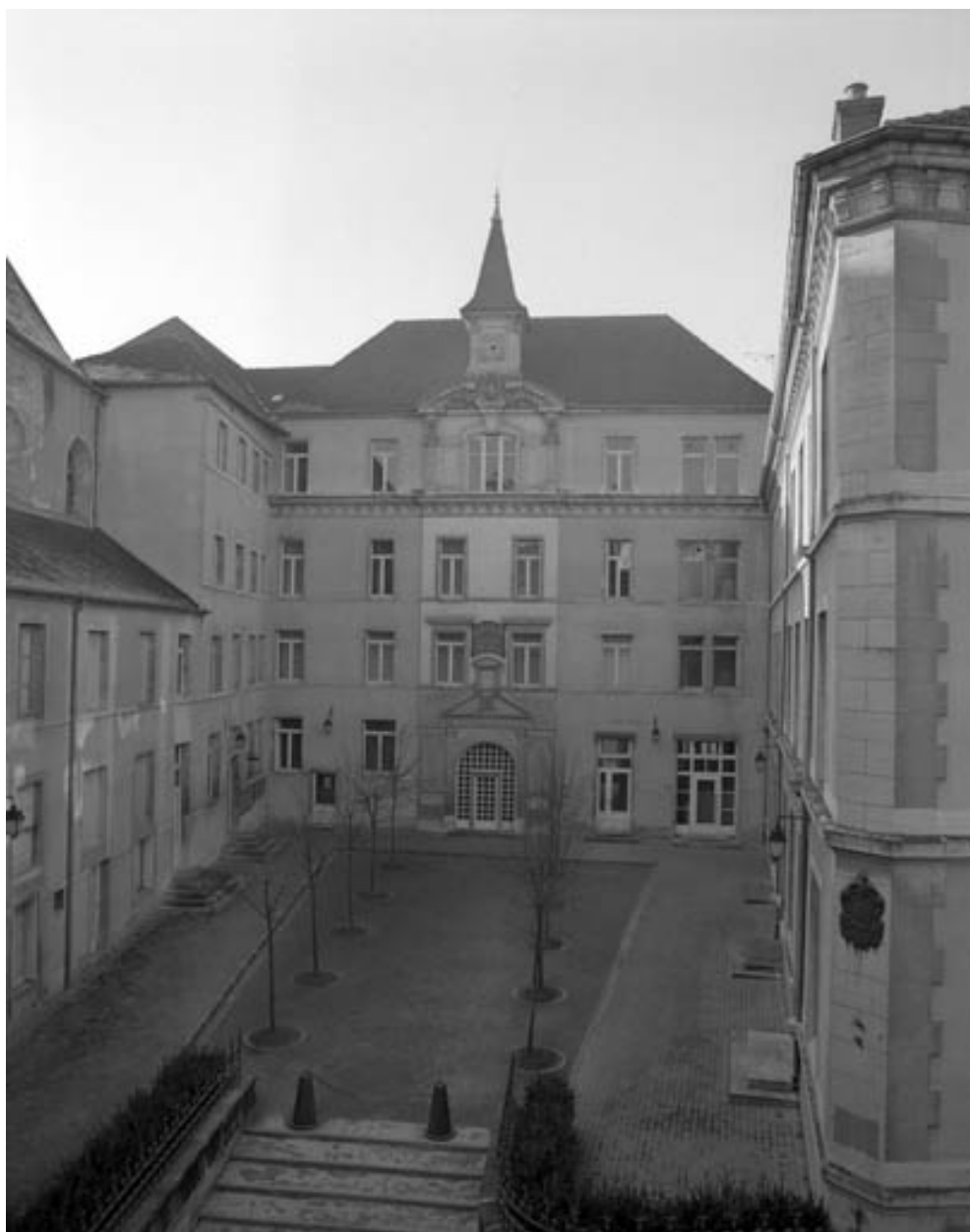
Façade antérieure du bâtiment principal en 1989.
