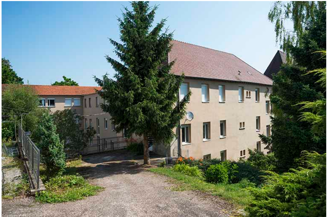
Angle sud-ouest du bâtiment d'administration.
