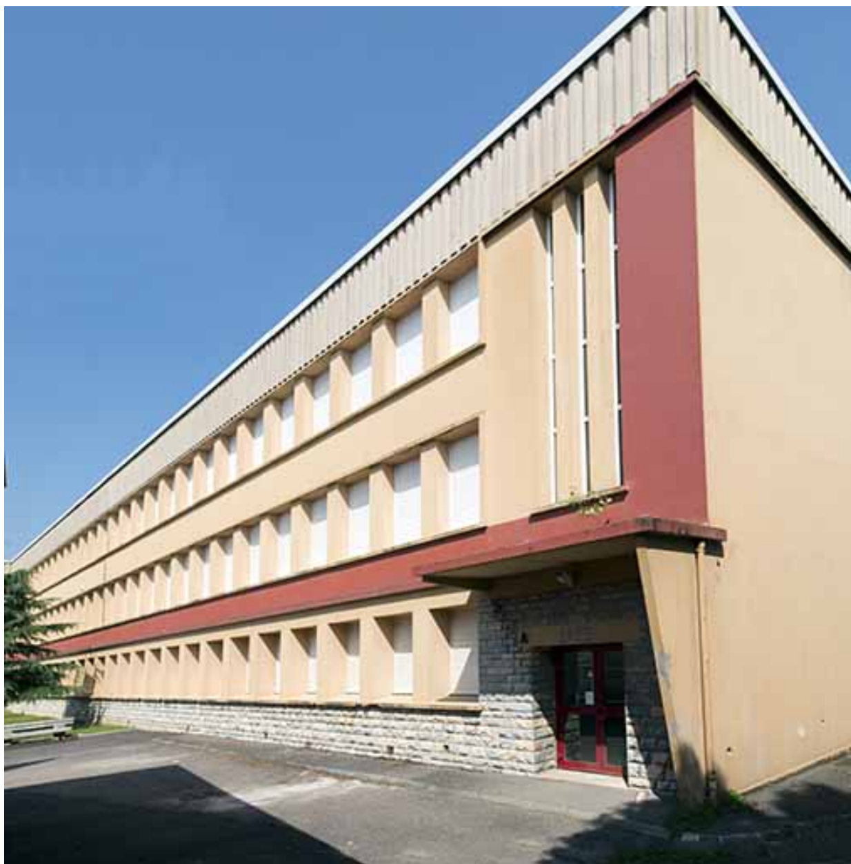
Angle sud-est de la barre d'externat nord.
