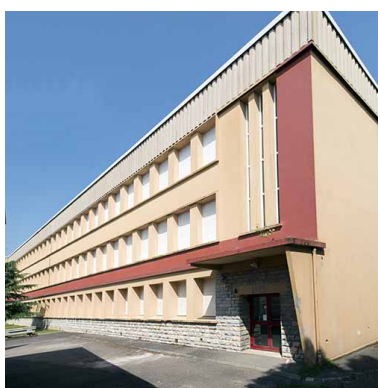
Angle sud-est de la barre d'externat nord.
