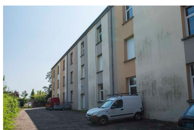
Façade nord de la barre d'externat nord.
