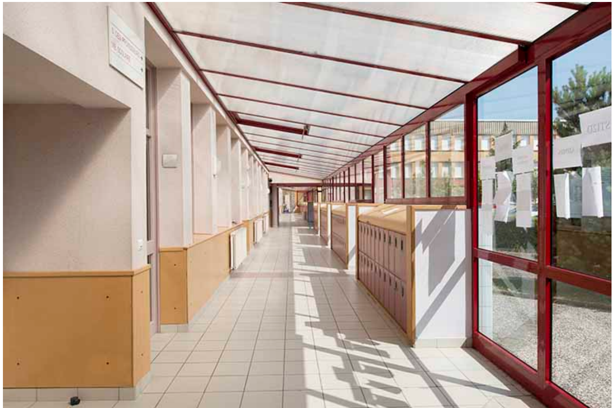
Couloir de la barre d'externat ouest.
