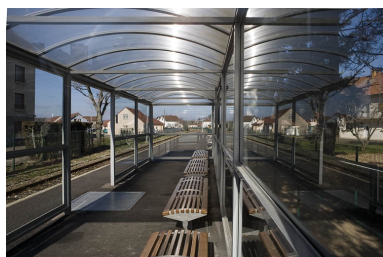
Intérieur. Phot. Yves Sancey IVR43_20073900060NUCA
