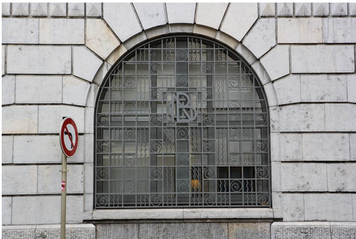
Détail d'une fenêtre du rez-de-chaussée.
