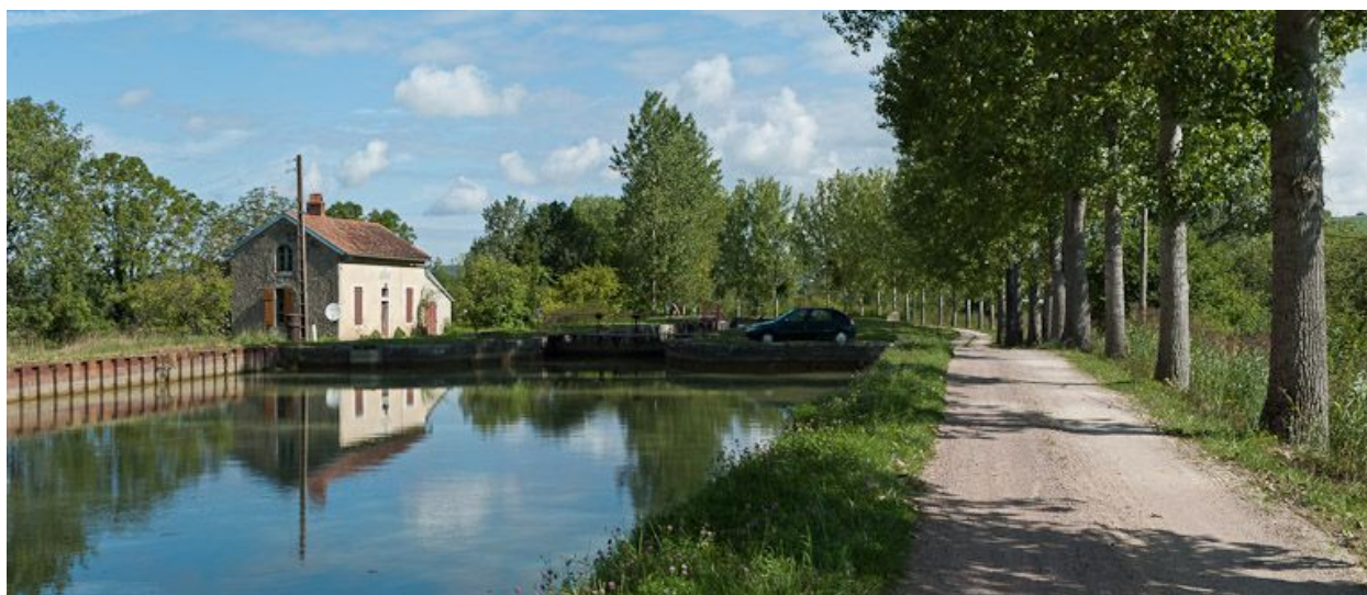
Vue du site d'écluse depuis l'amont.
