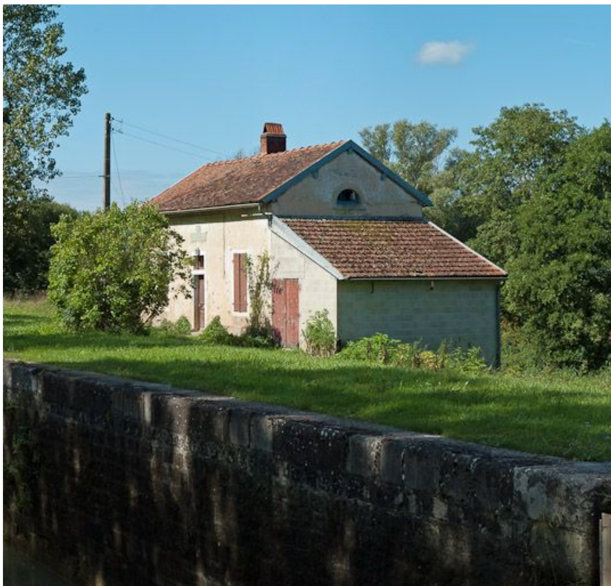
Vue de la maison éclusière.
