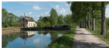
Vue du site d'écluse depuis l'amont. Phot. Pierre-Marie Barbe-Richaud IVR26_20112103948NUC4AQ
