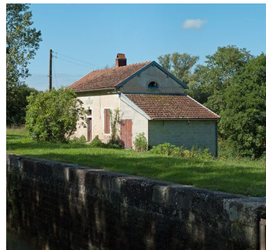
Vue de la maison éclusière. Phot. Pierre-Marie Barbe-Richaud IVR26_20112103950NUC2AQ
