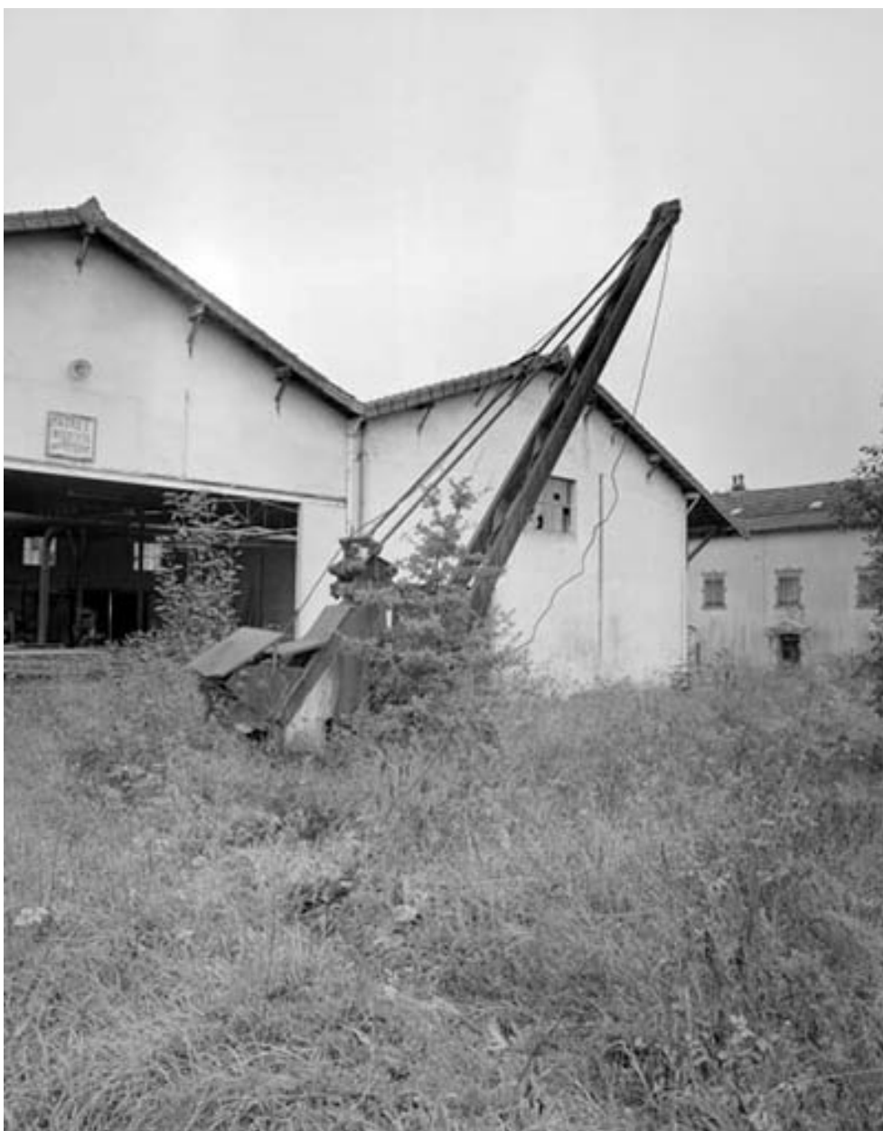
Grue sur l'aire des matières premières.
