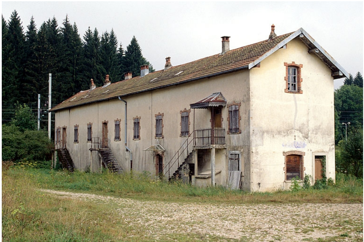
Façade antérieure du logement ouvrier.
