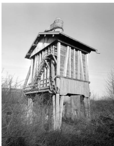
Silo à sciure. Phot. Yves Sancey IVR43_19983900030X
