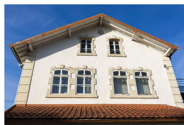
Façade latérale droite : fenêtres de niveaux supérieurs.
