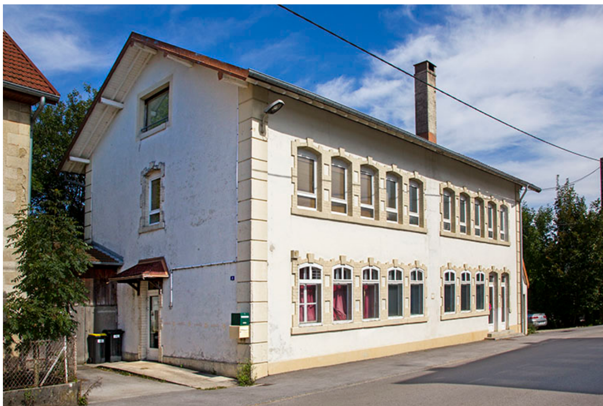
Façades antérieure et latérale gauche.
