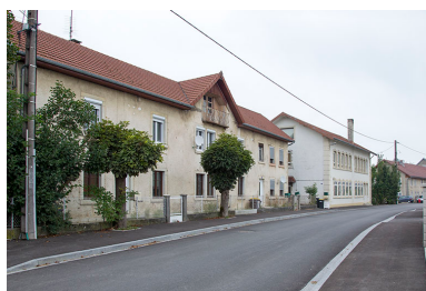
Vue d'ensemble, depuis le sud (façade antérieure).
