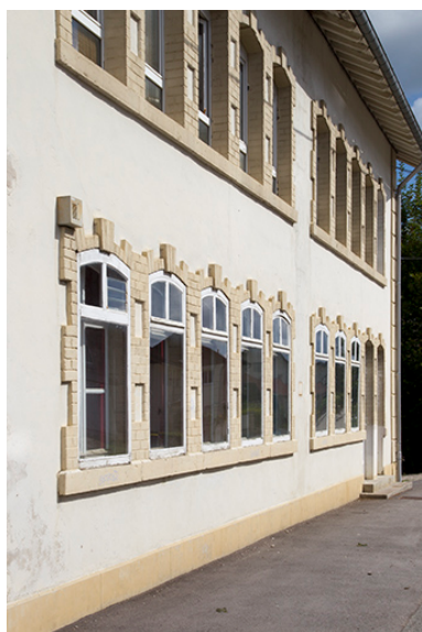
Façade antérieure : fenêtres multiples vues en enfilade.
