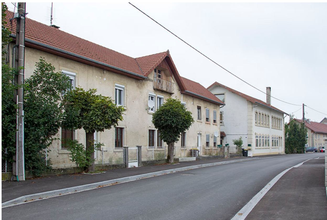
Vue d'ensemble, depuis le sud (façade antérieure).
