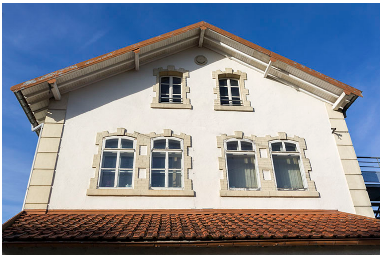
Façade latérale droite : fenêtres de niveaux supérieurs.
