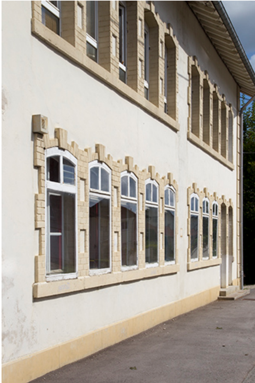
Façade antérieure : fenêtres multiples vues en enfilade.
