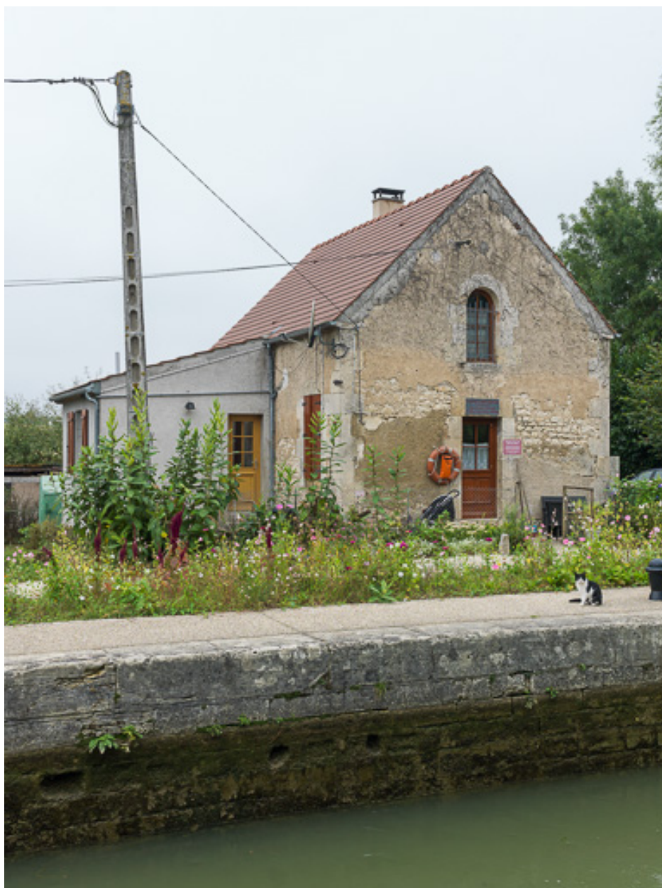
Vue de la maison éclusière.
