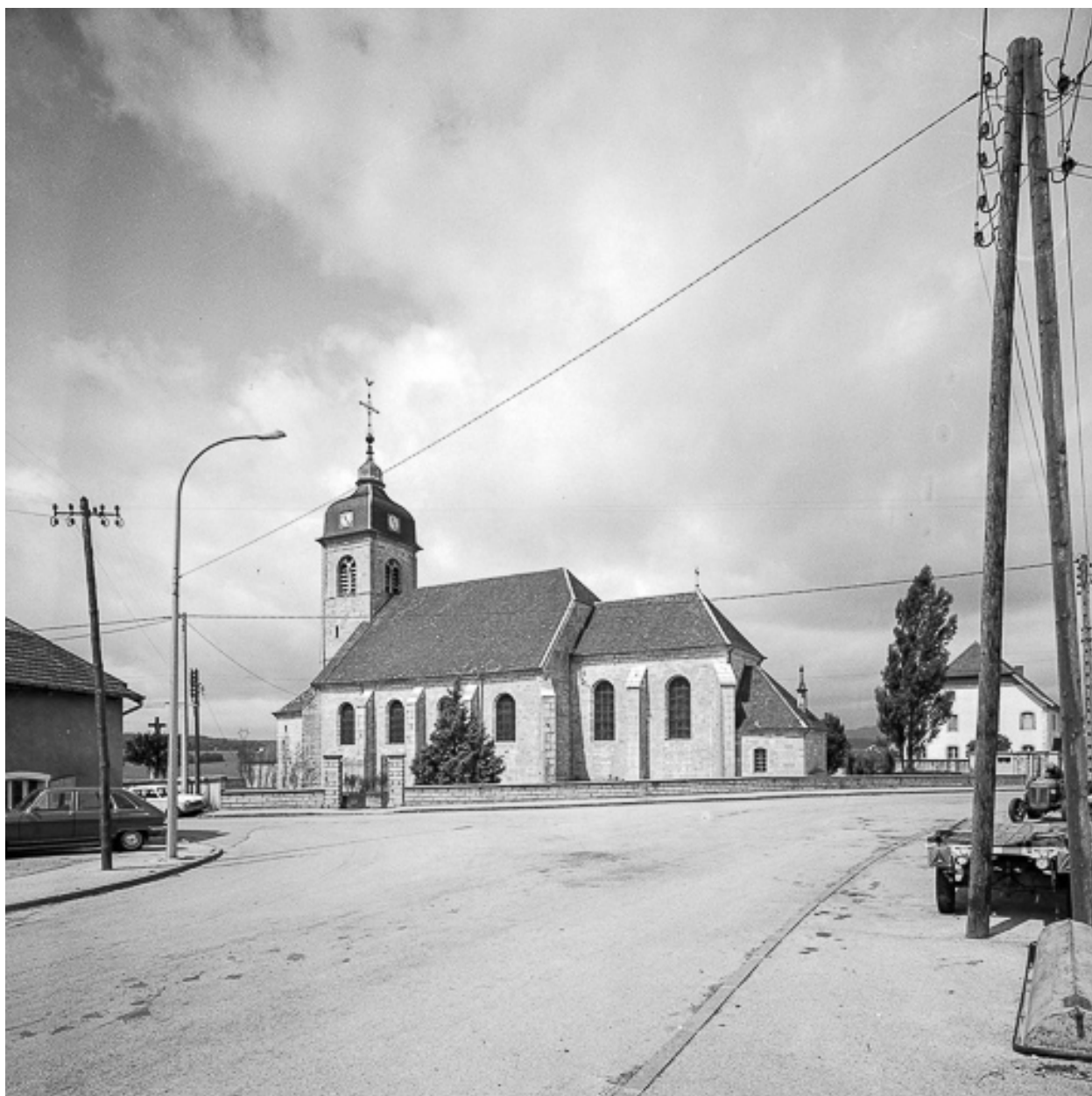
Façade latérale droite.
