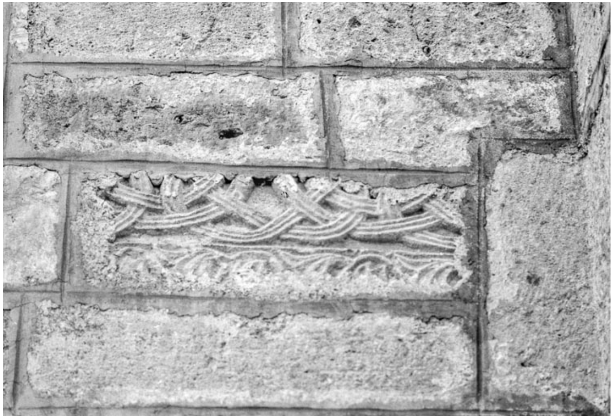
Extérieur : détail mur droit de la nef.
