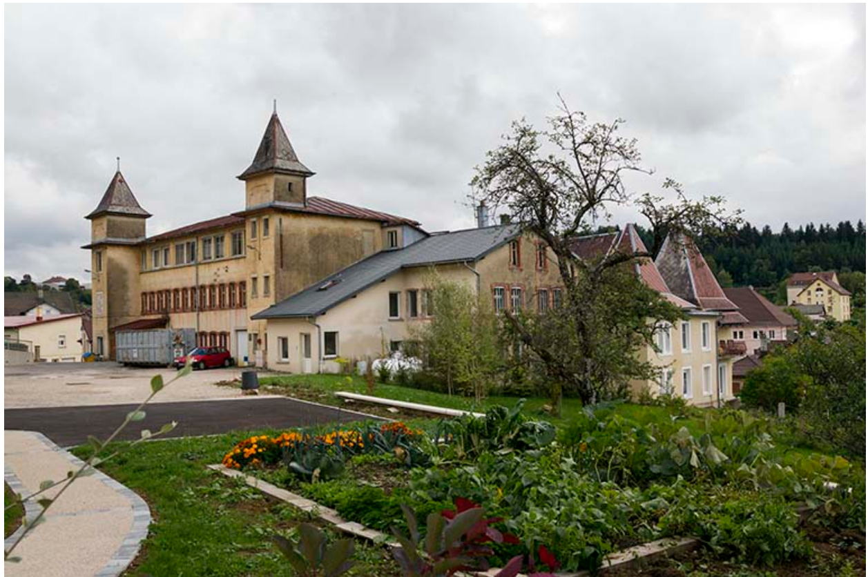
Usine : vue d'ensemble, depuis le nord-ouest.
