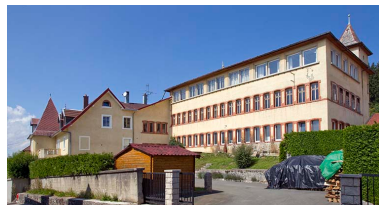
Usine : vue d'ensemble, depuis la rue du Mont à l'est.
