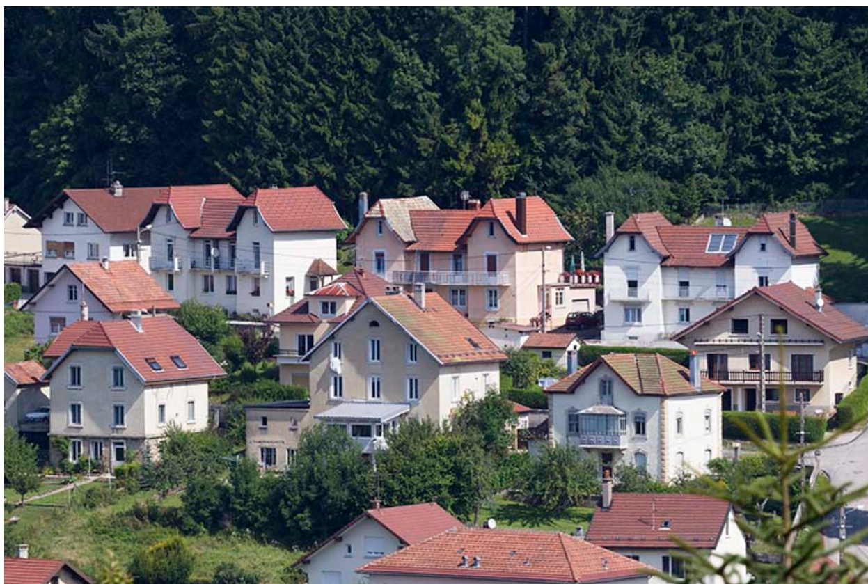
Cité de Montjoie : vue d'ensemble des trois immeubles orientaux (n° 1, 3 et 5-7).
