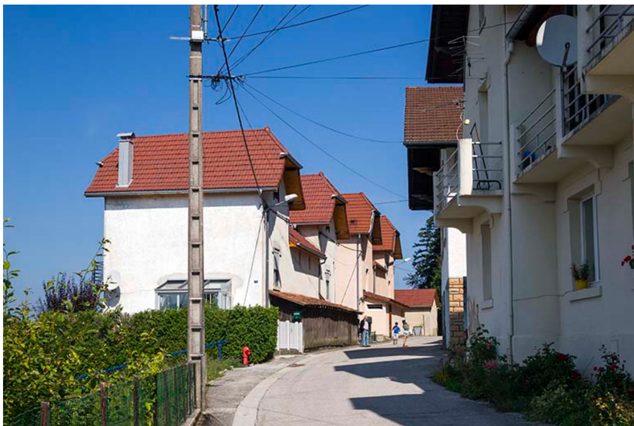
Cité de Montjoie : immeubles n° 6 et 4 à gauche, n° 1 à droite.
