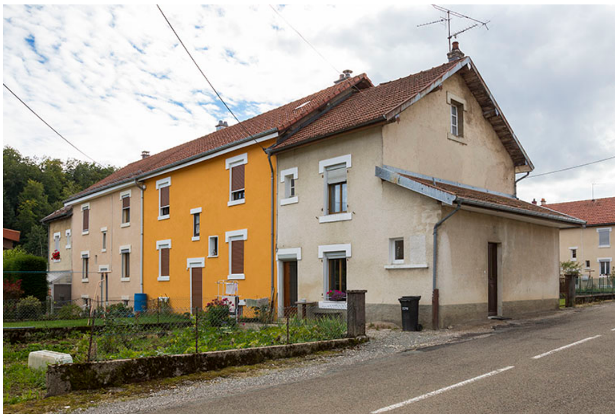
Cité Rotschi : immeuble au n° 9.
