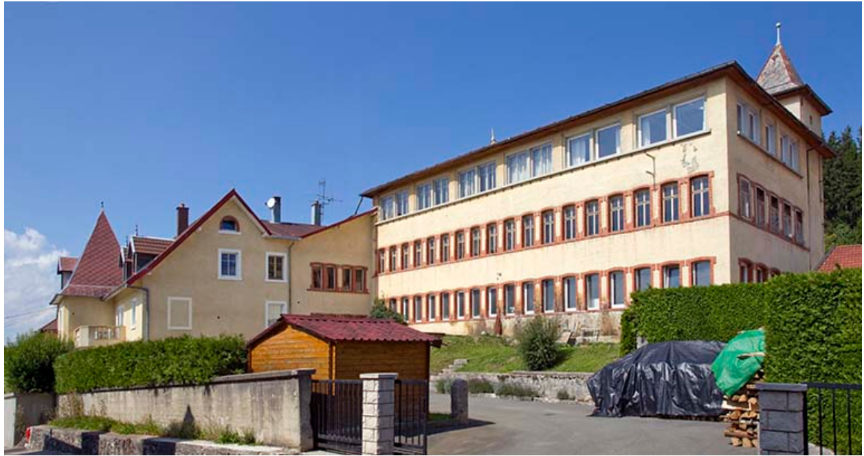
Usine : vue d'ensemble, depuis la rue du Mont à l'est.
