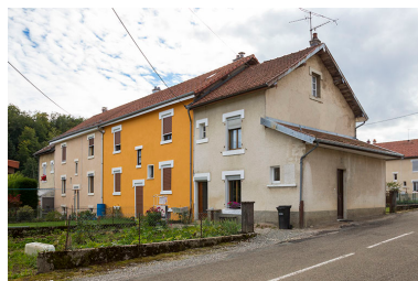
Cité Rotschi : immeuble au n° 9.
