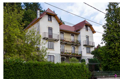
Cité de Montjoie : immeuble n ° 6, façade côté vallée (ouest).
