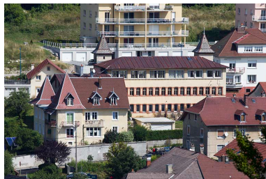
Usine, n° 7-9 rue du Mont : vue d'ensemble, depuis le sud.
