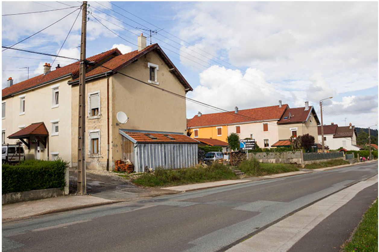
Cité Rotschi, n° 7-11 avenue du Maréchal Leclerc : vue d'ensemble, depuis l'ouest.
