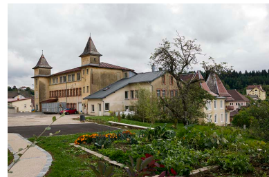
Usine : vue d'ensemble, depuis le nord-ouest.
