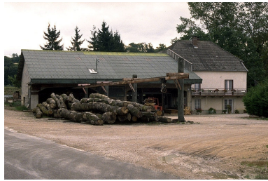
Vue d'ensemble. Phot. Jérôme Mongreville IVR43_19953900410ZA
