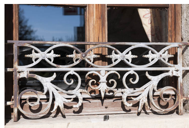
Façade sur la rue des Glacis, détail : le garde-corps en fonte d'une fenêtre du rez-de-chaussée. Phot. Jérôme Mongreville IVR43_20127000501NUC4A
