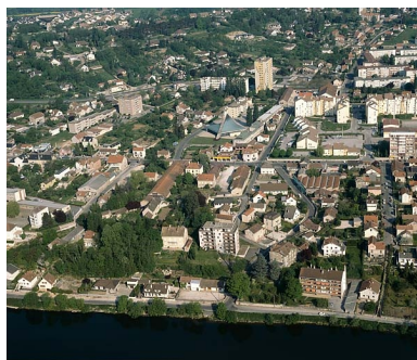
Vue d'ensemble depuis le sud-est, photographie aérienne. Phot. Yves Sancey IVR43_19903900255XA
