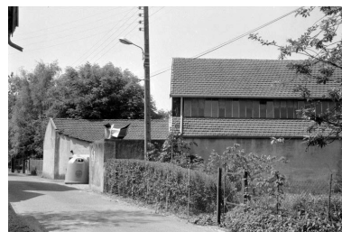
Extrémité postérieure de la seconde unité. Phot. Laurent Poupard IVR43_19893900186Z
