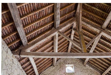
Charpente et oculus.
