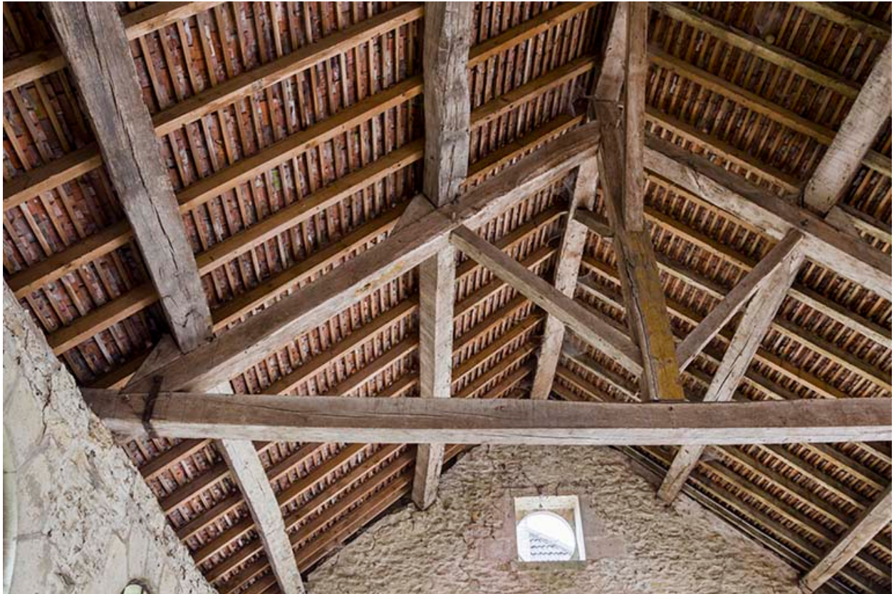
Charpente et oculus.
