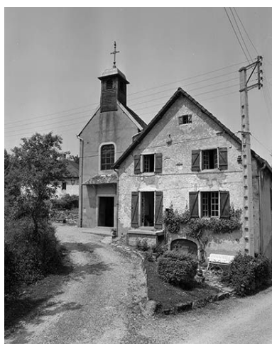
Chapelle Notre-Dame-du-Haut- Ciel située rue Ferdinand de Rye. Phot. Yves Sancey IVR43_19812500237X
