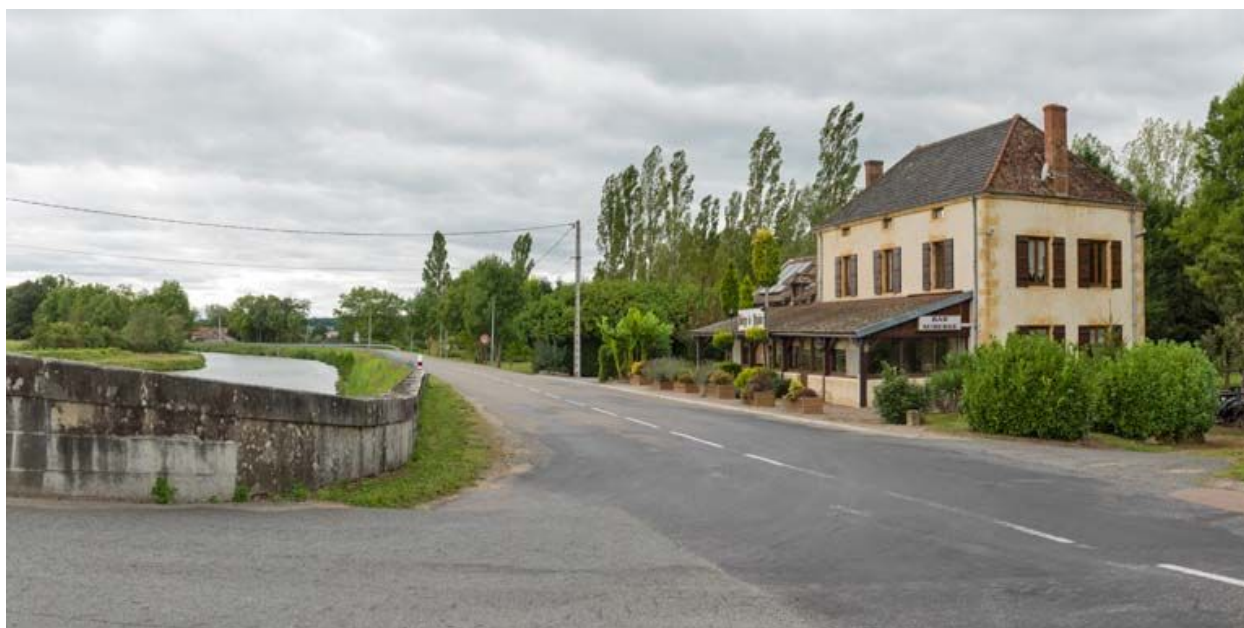
Vue d'ensemble du restaurant et du canal.
