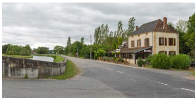
Vue d'ensemble du restaurant et du canal.
