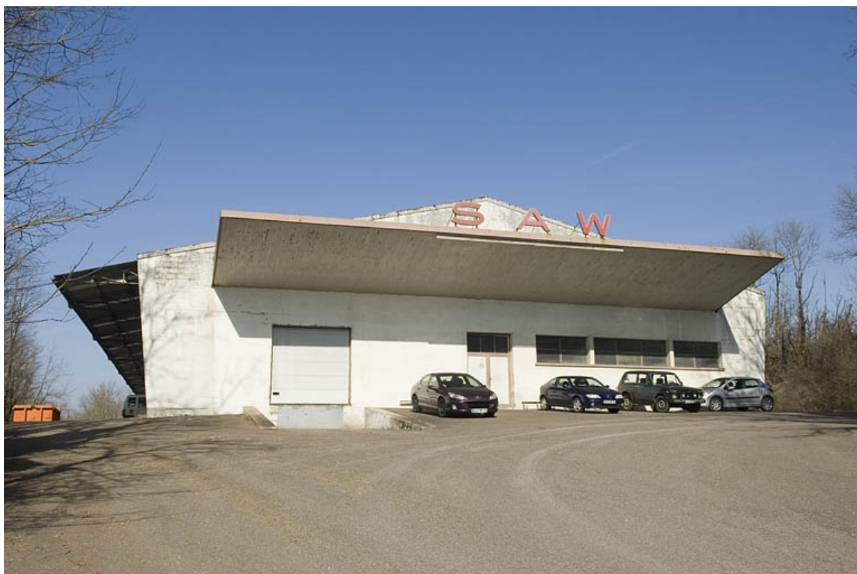
Mur-pignon de l'atelier de fabrication (rondelles).
