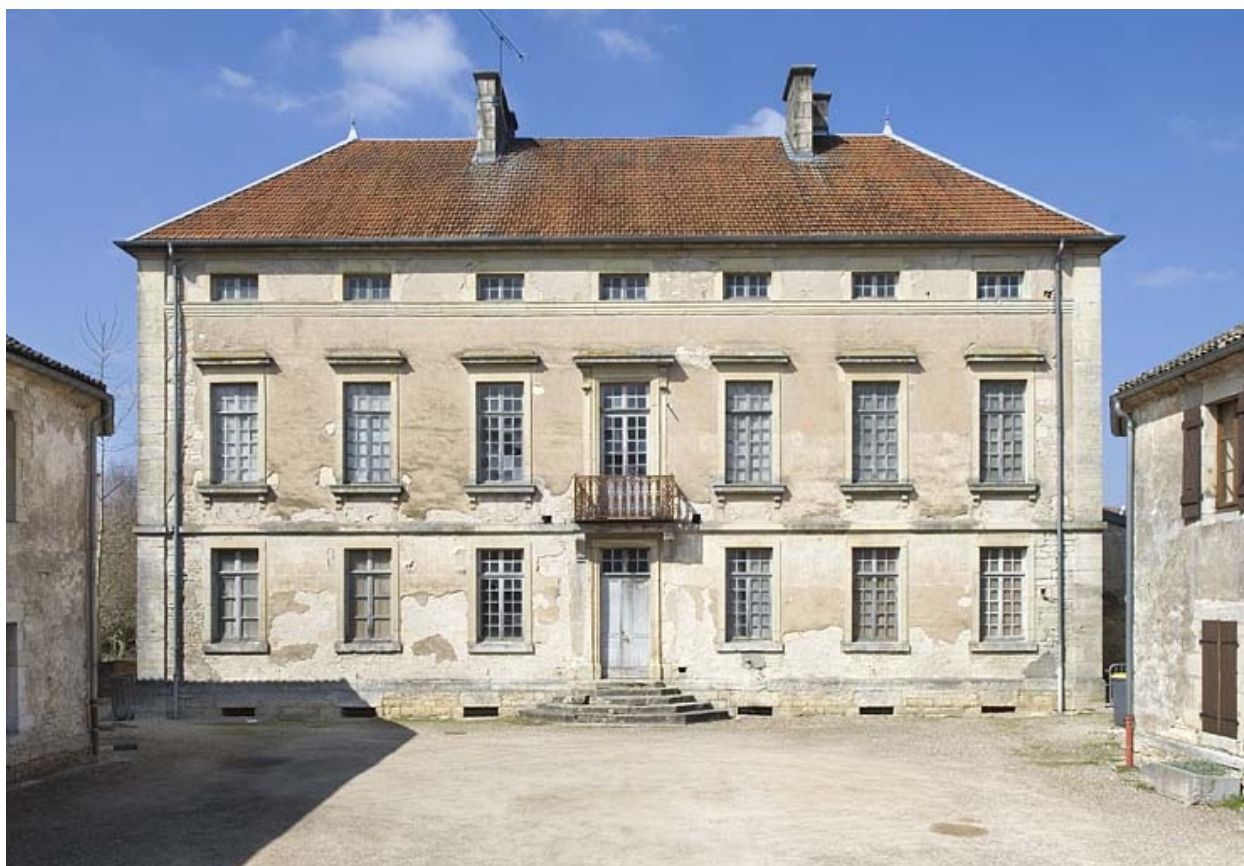
Logement patronal (31 rue Carnot). Façade antérieure.
