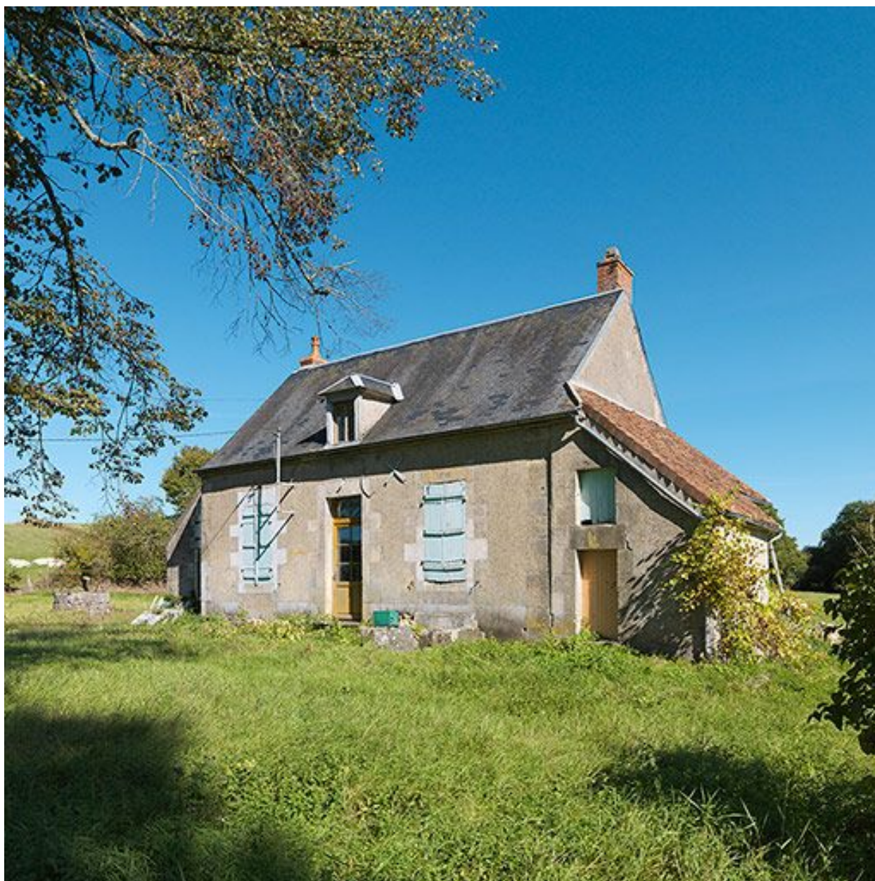
La maison éclusière, vue de 3/4.
