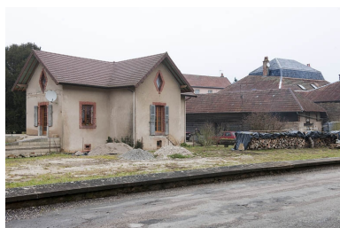
Bâtiment isolé à l'ouest. Phot. Jérôme Mongreville IVR43_20112502920NUC4A
