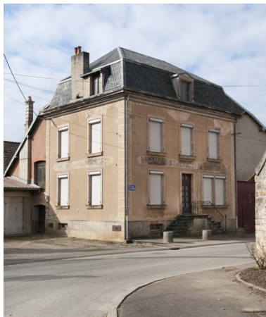
Vue rapprochée. Phot. Jérôme Mongreville IVR43_20112500335NUC4A
