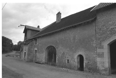
Ferme située rue du Mont. Phot. Bernard Lardière IVR43_19817000229Z
