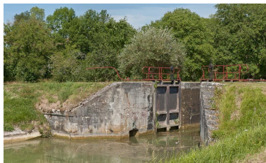
Vue du sas d'écluse en aval. Phot. Pierre-Marie Barbe-Richaud IVR26_20118900334NUC4AQ
