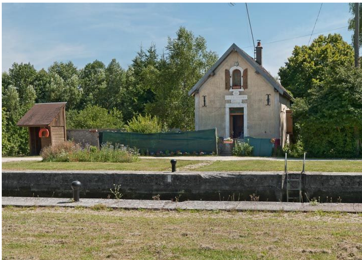
Vue d'ensemble du site d'écluse.
