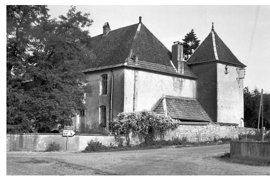
Maison située rue de la Foire. Phot. Bernard Lardière IVR43_19797000238Z
