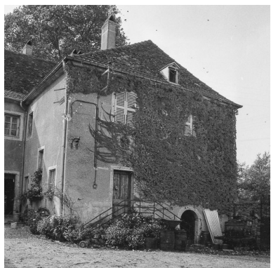
Ferme située rue des Enclos. Phot. Bernard Lardière IVR43_19797000253Z
