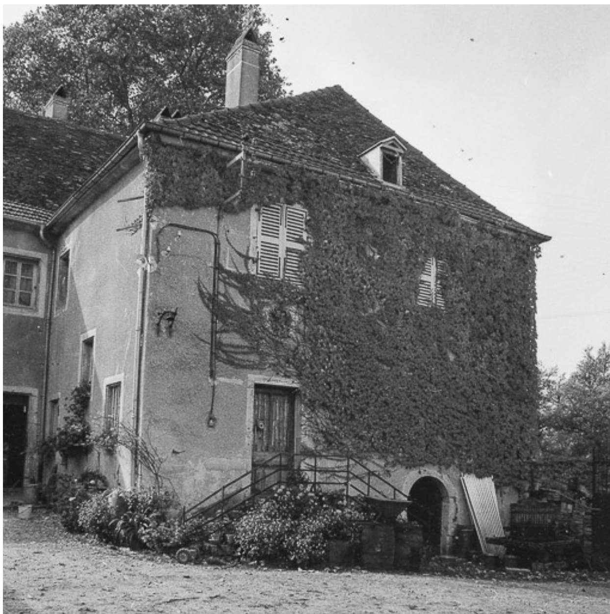
Ferme située rue des Enclos.
