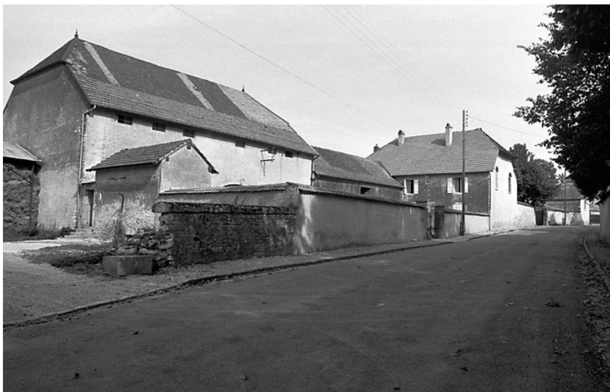
Ferme située rue du Malpierre.
