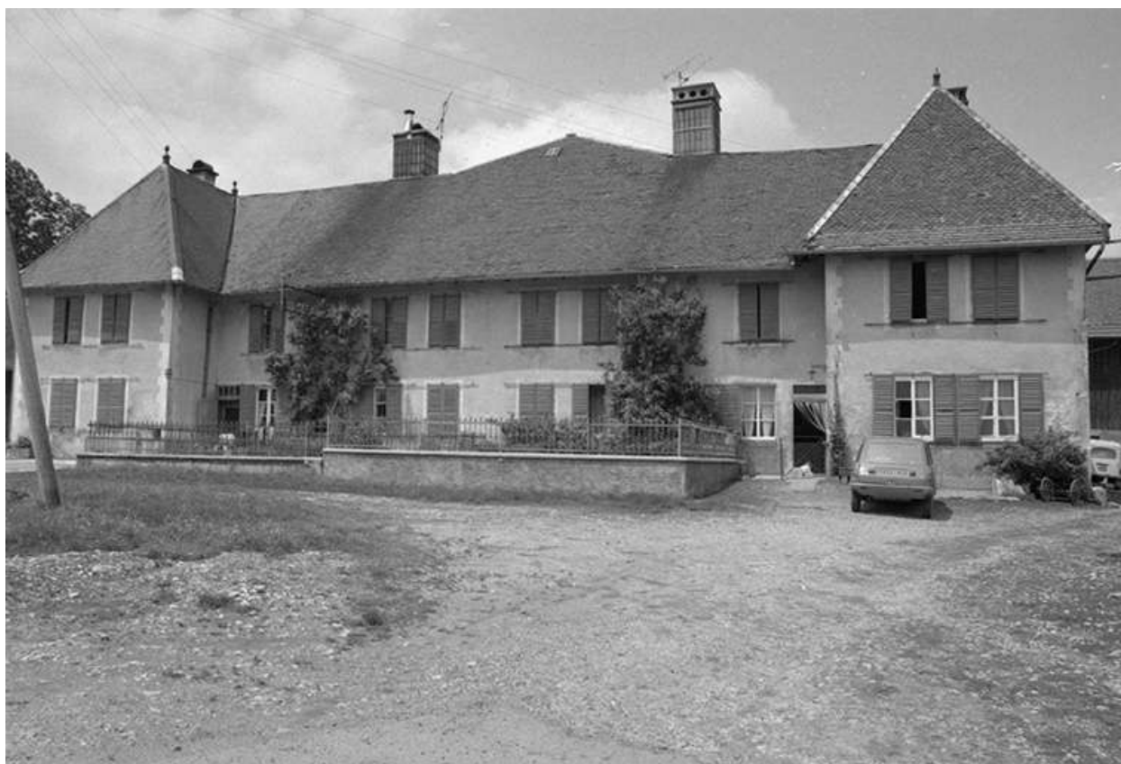
Ferme située 1 Grande Rue : façade antérieure.
