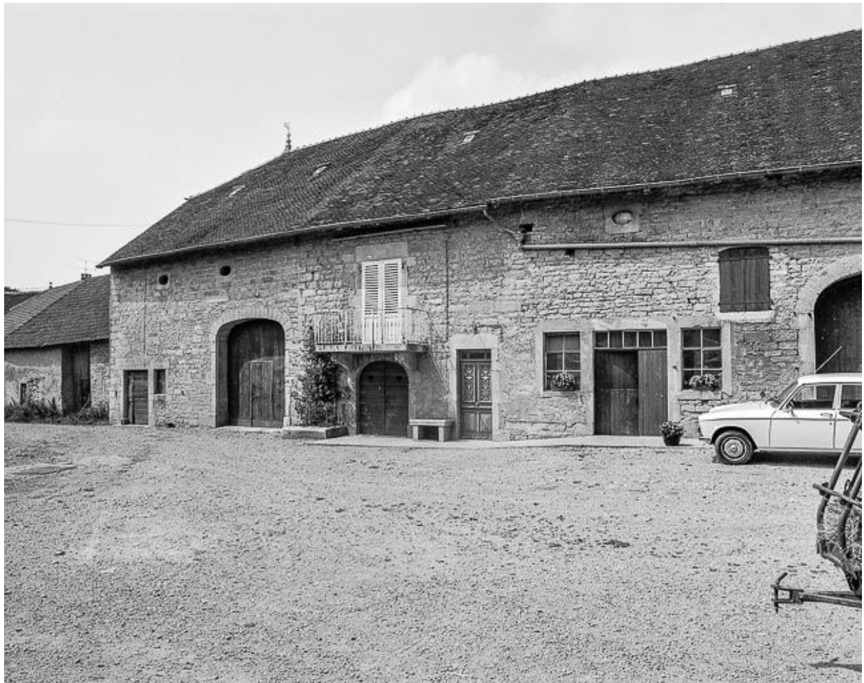
Ferme située 169 rue Saint-Néron.
