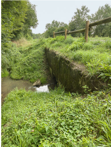
Vue de l'aqueduc. Phot. Pierre-Marie Barbe-Richaud IVR26_20175800142NUC2A
