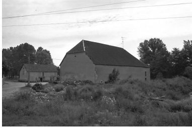
Vue d'ensemble. Phot. Bernard Lardière IVR43_19817000251Z
