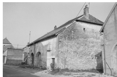
Ferme située 17 Grande Rue : façade antérieure vue de trois quarts droit. Phot. Bernard Lardière IVR43_19797000168Z
