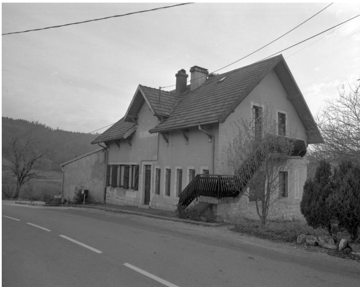
Façade antérieure et face droite.
