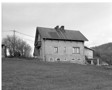
Façade postérieure. Phot. Jérôme Mongreville IVR43_19943901261X
