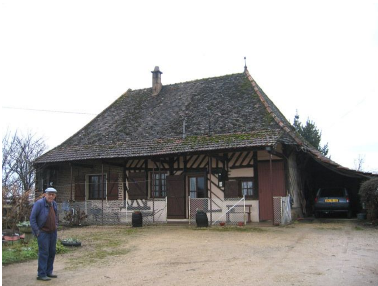
Vue d'ensemble de la façade.
