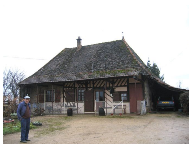
Vue d'ensemble de la façade.
