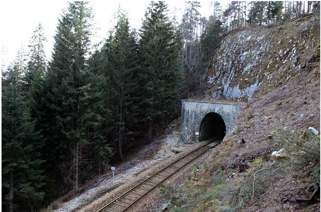
Vue plongeante sur la tête côté Andelot-en-Montagne.
