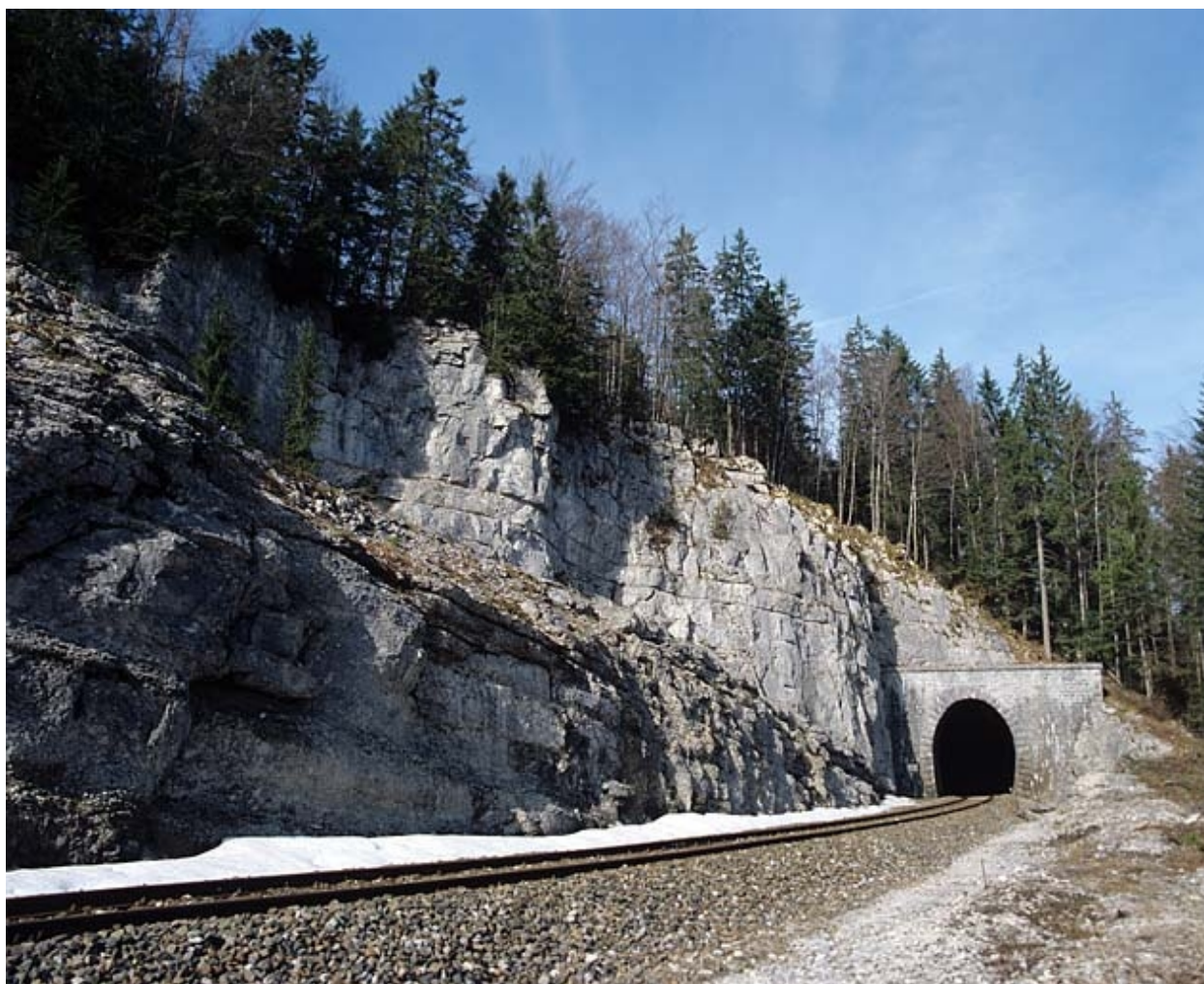
Tête côté La Cluse et paroi rocheuse.
