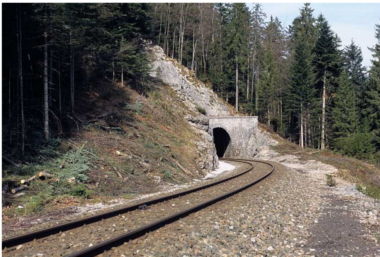
Voie et tête côté La Cluse.
