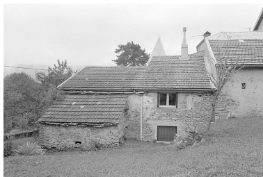
Face sud-est. Phot. Jérôme Mongreville IVR43_19963901450X
