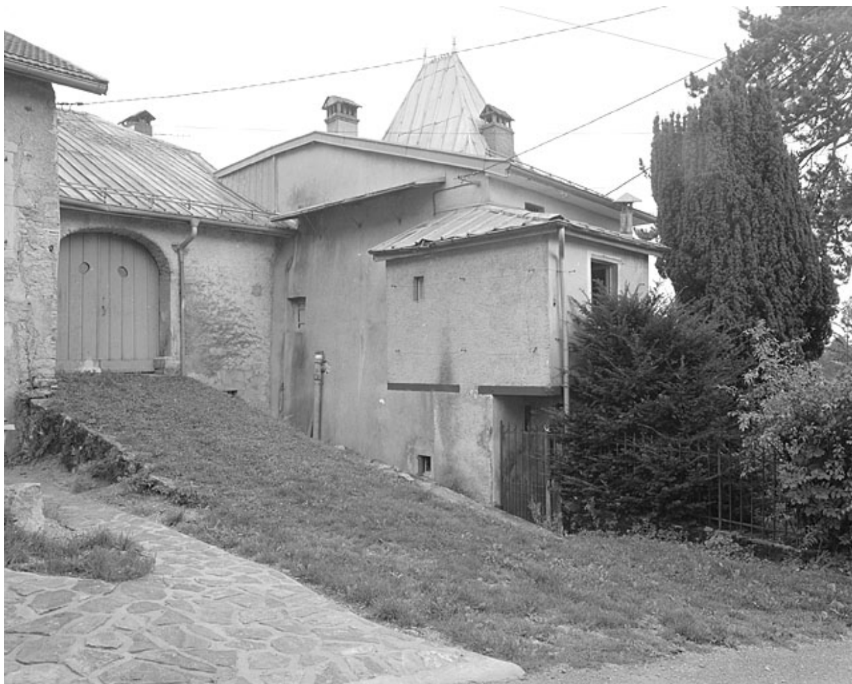
Façade postérieure de la demeure.
