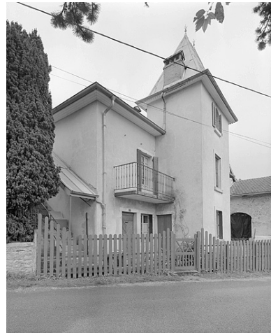
La tourelle. Phot. Jérôme Mongreville IVR43_19963901448V
