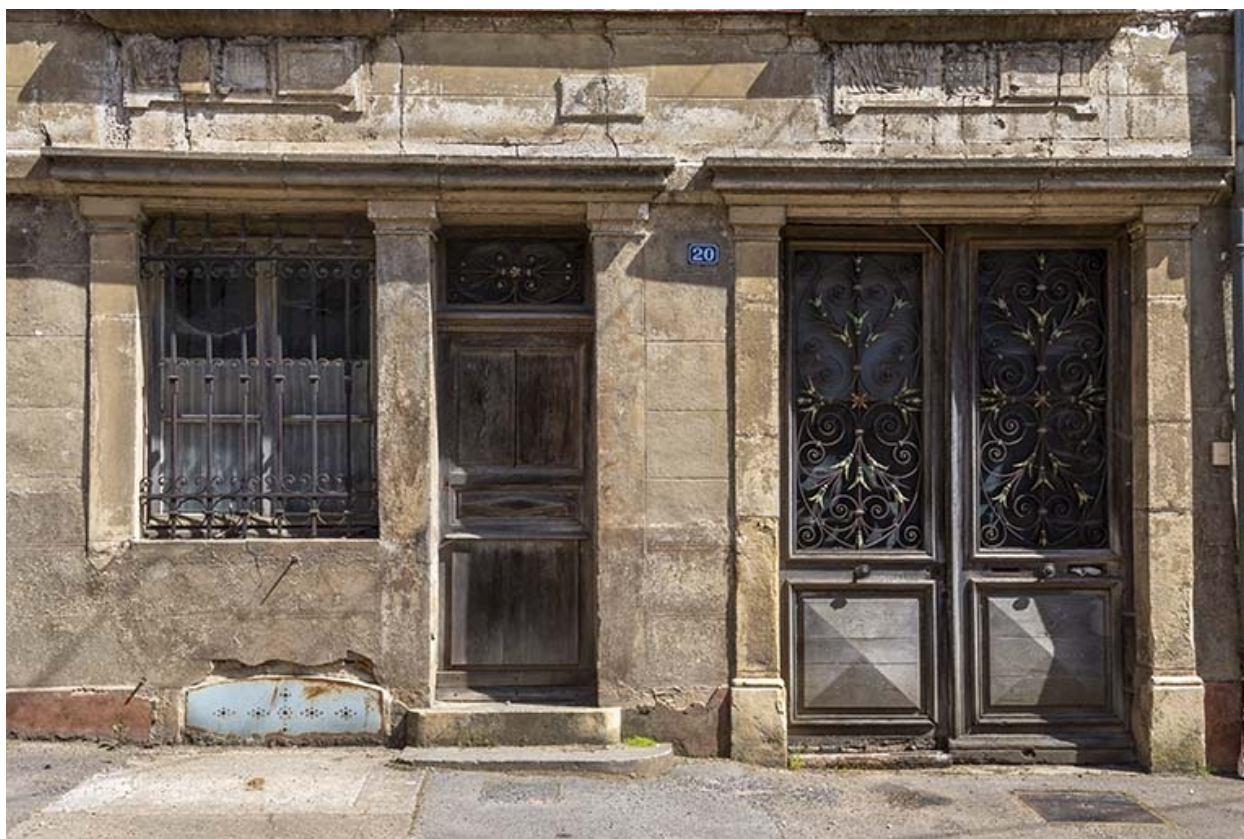
Pilastres, ferronnerie, menuiserie, bas-relief sur la façade.
