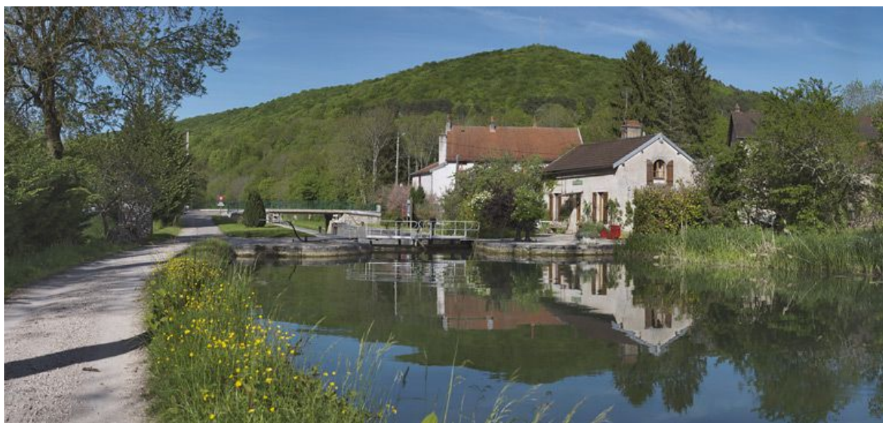
Vue d'ensemble de l'amont du site d'écluse.
