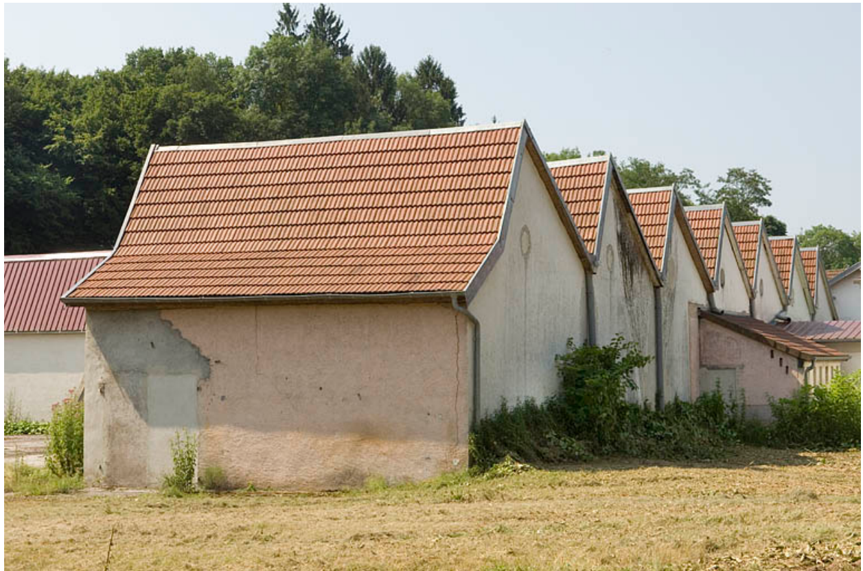
Atelier de fabrication couvert de sheds.
