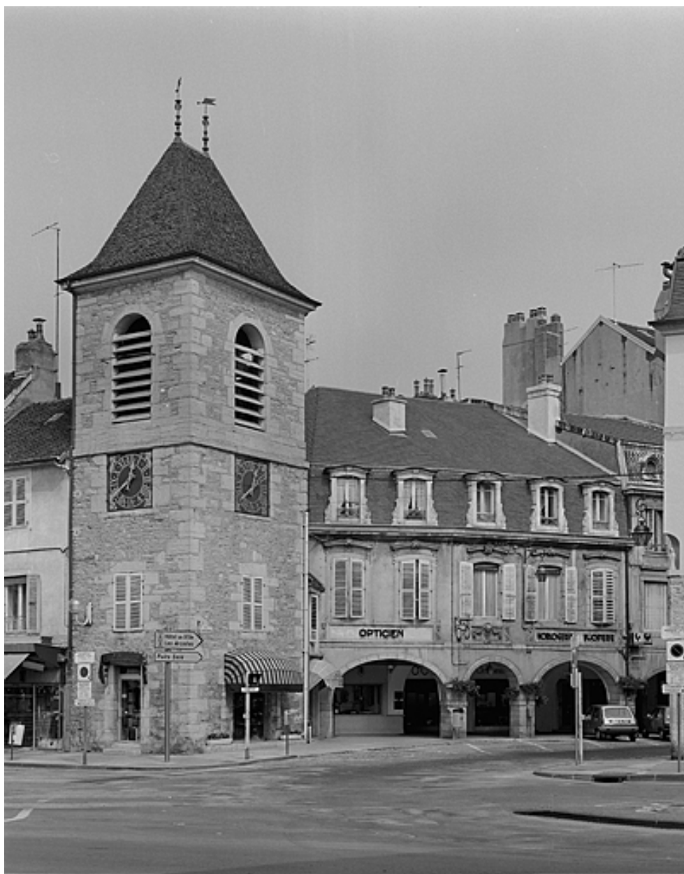
Beffroi dit Tour de l'Horloge, situé place de la Liberté.
