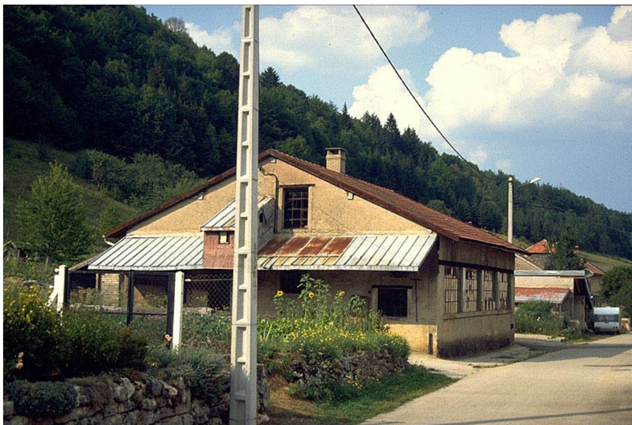
Façades antérieure et latérale droite.
