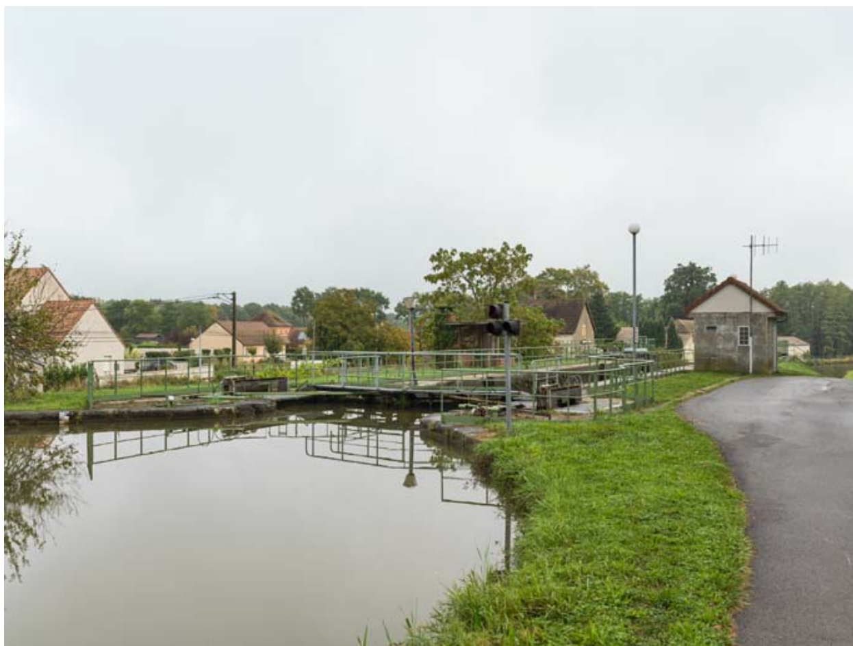
Vue d'ensemble du site d'écluse.
