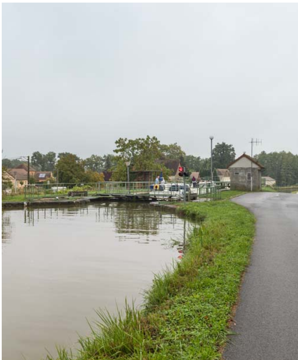
Vue d'ensemble du site d'écluse.
