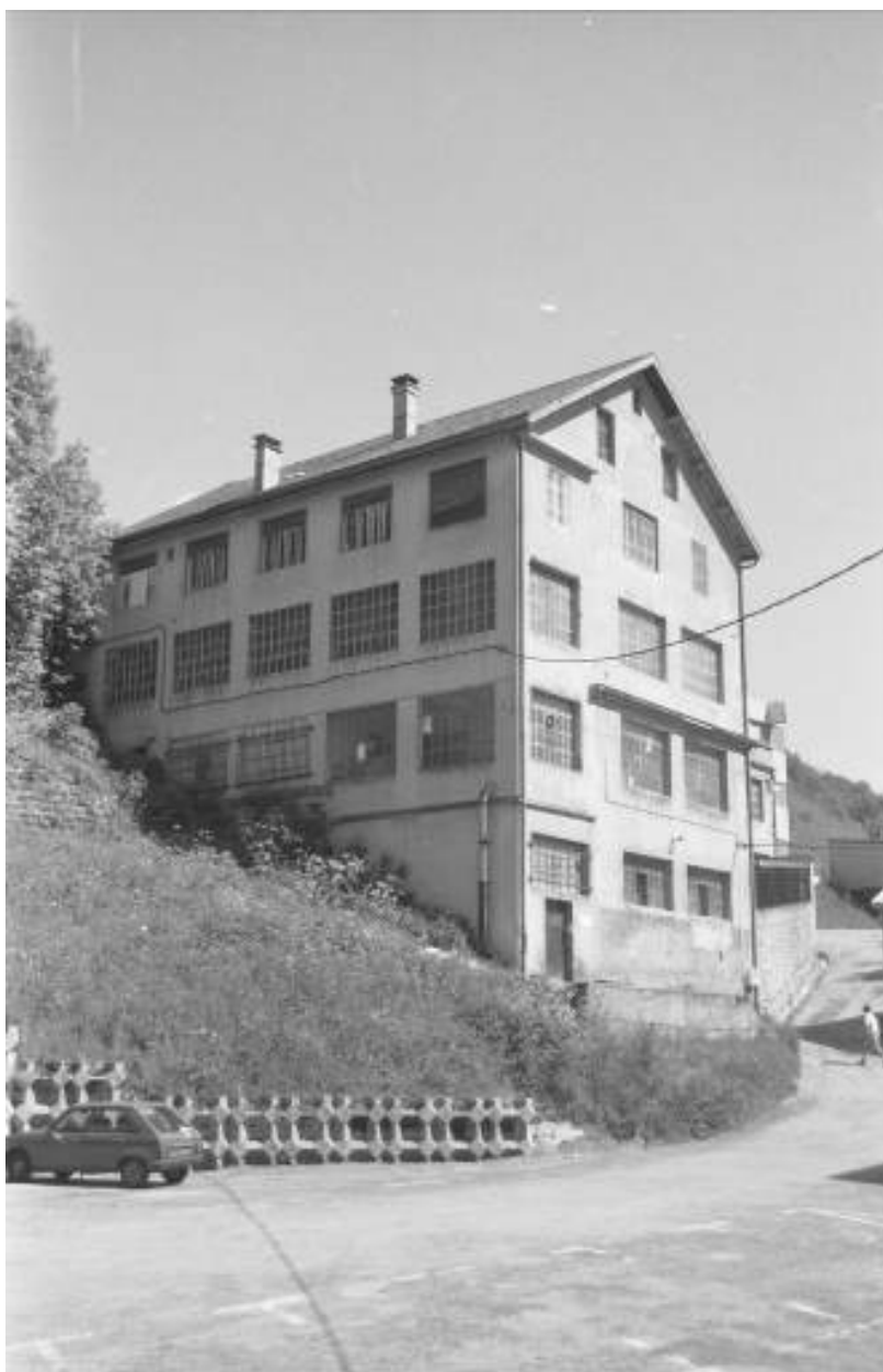
Façades postérieure et latérale droite.
