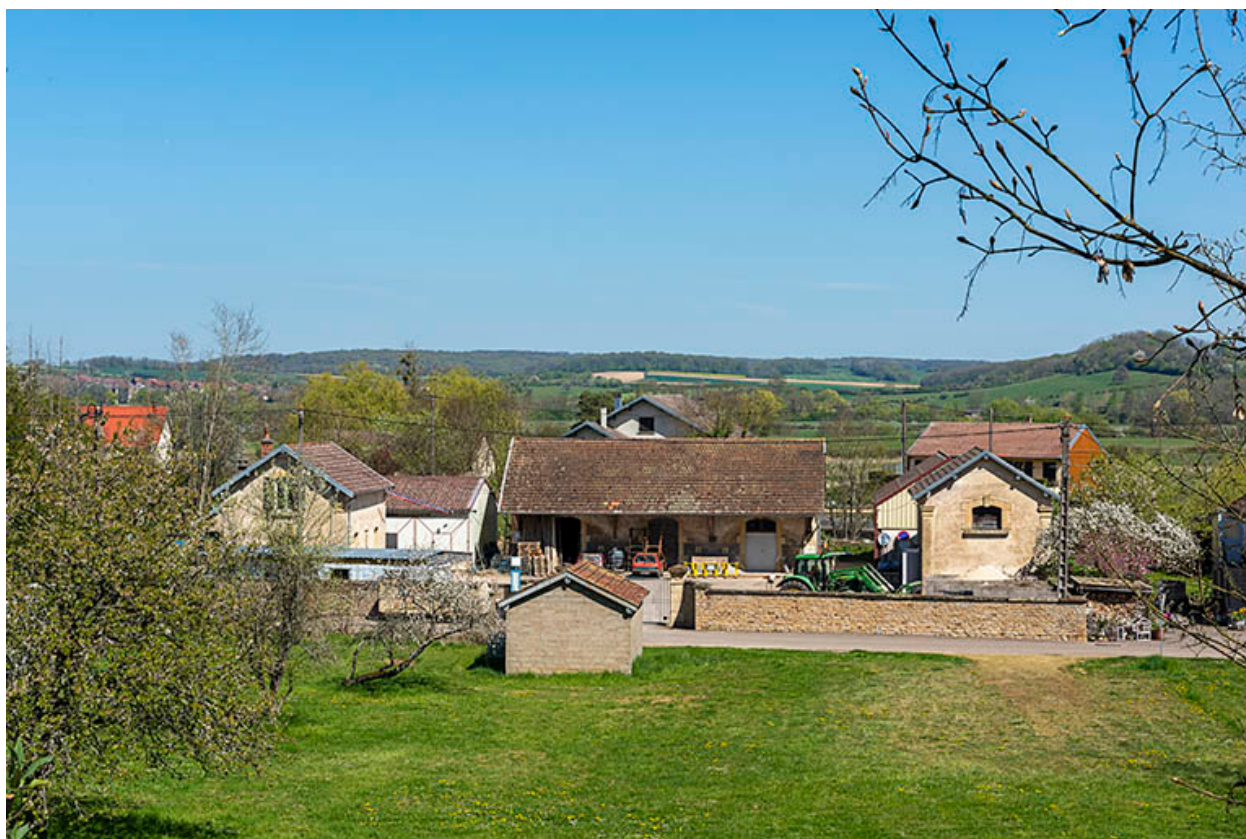
L'ensemble des bâtiments de l'ancien abattoir.
