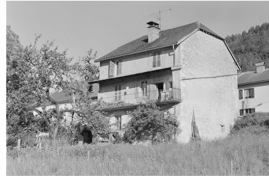
Maison, magasin de commerce à la Rixouse. Phot. Jérôme Mongreville IVR43_19973900753X
