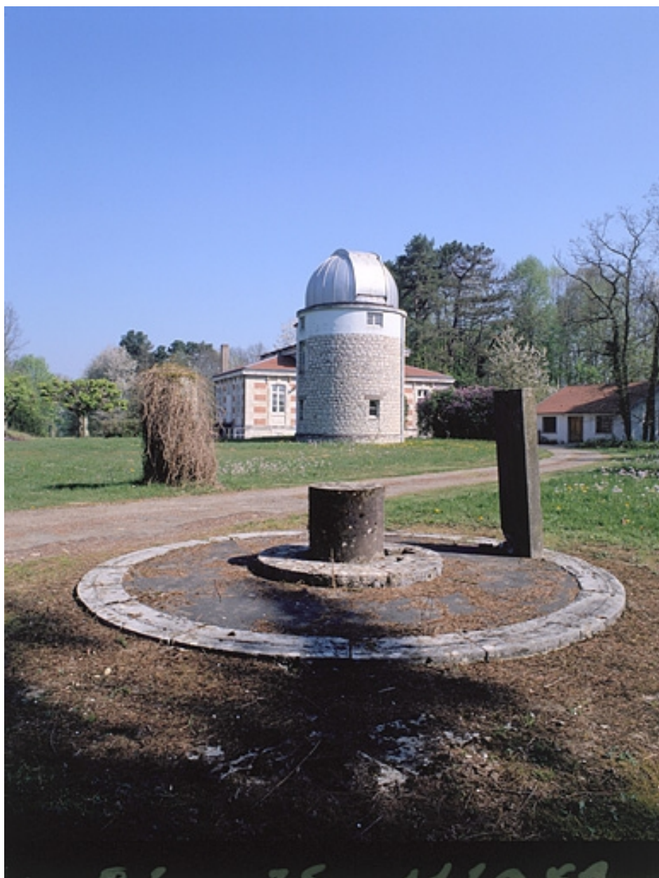
Vue d'ensemble des vestiges de la seconde coupole de la lunette. L'instrument reposait sur le pilier central ; les autres piliers étaient destinés à la mire et à l'horloge.
