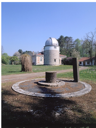
Vue d'ensemble des vestiges de la seconde coupole de la lunette. L'instrument reposait sur le pilier central ; les autres piliers étaient destinés à la mire et à l'horloge. Phot. Jérôme Mongreville IVR43_20022501120XA
