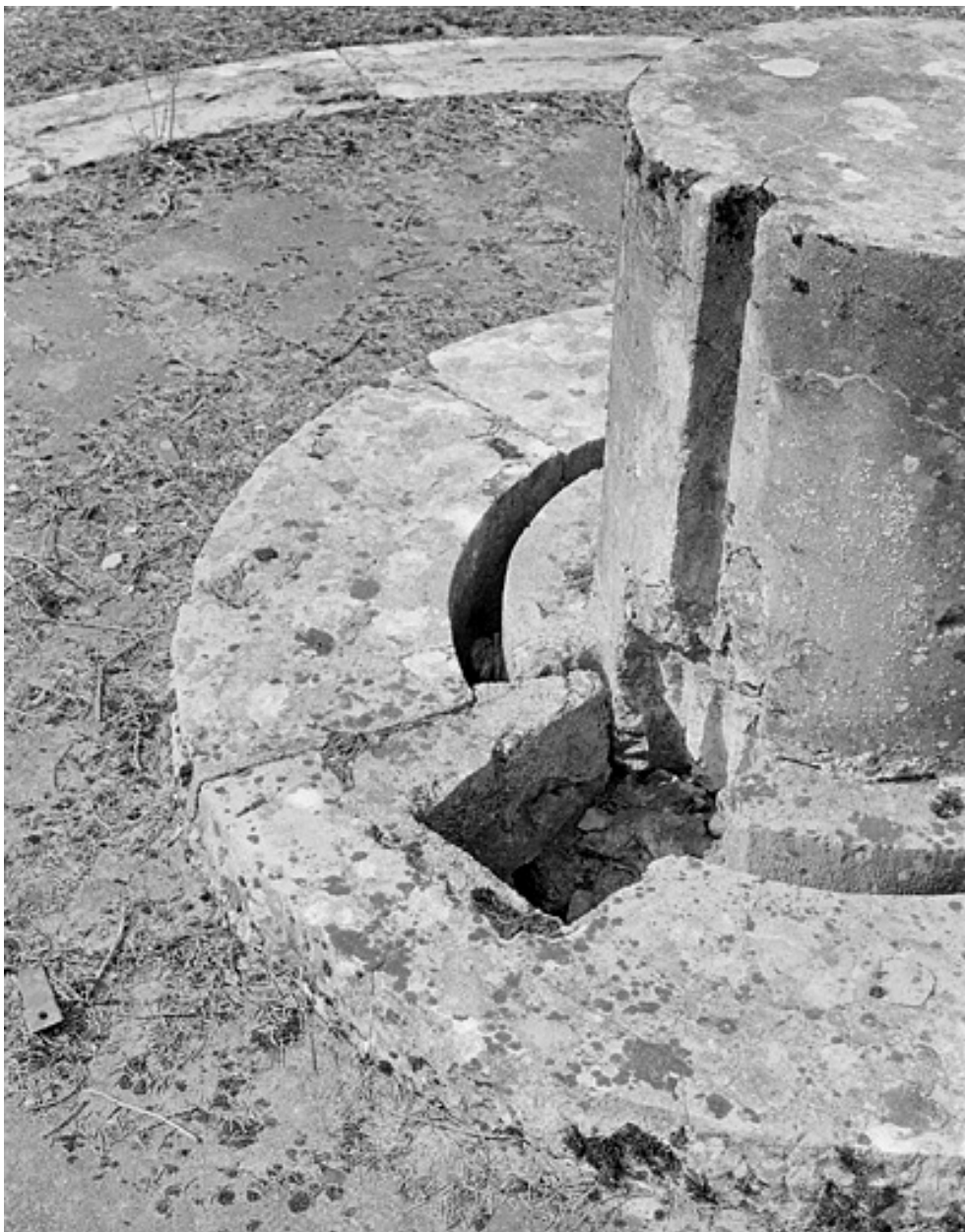
Base du pilier central, sur lequel reposait l'instrument. L'espace isole le pilier du sol du reste du bâtiment.
