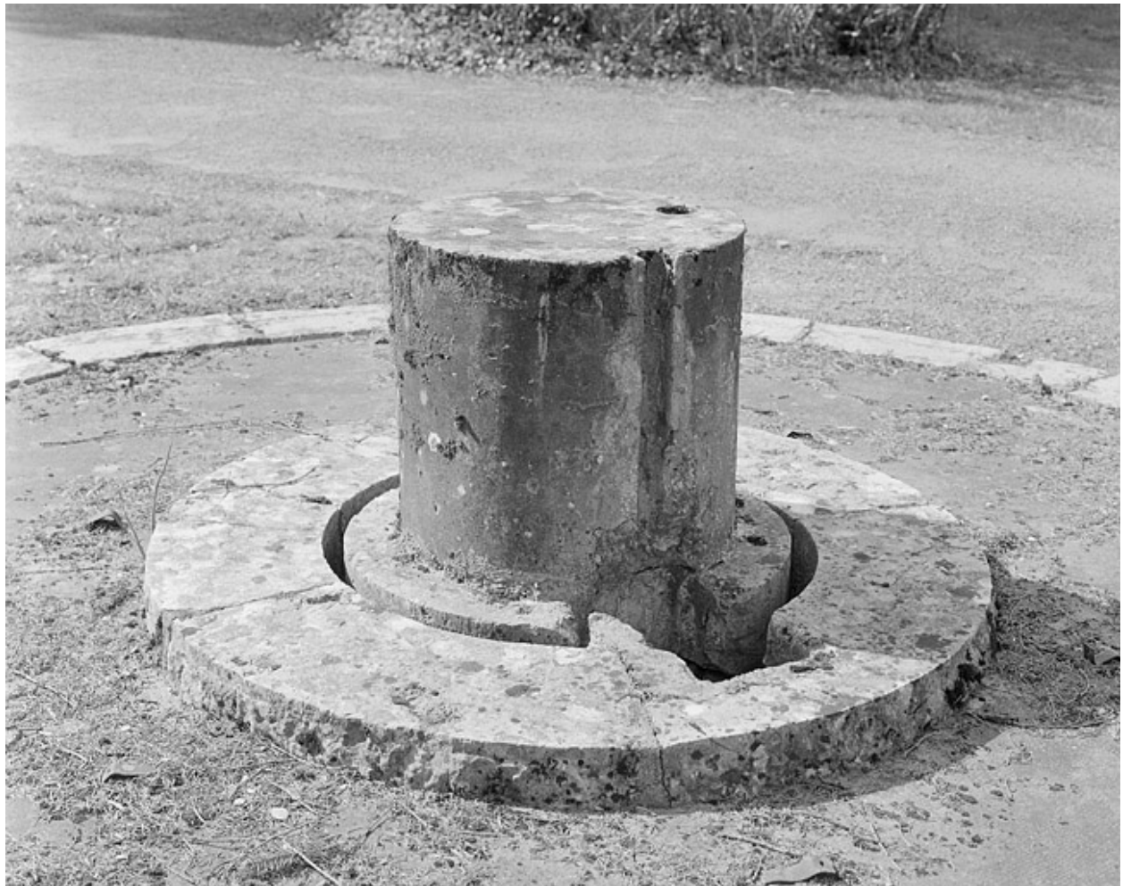
Base du pilier central, sur lequel reposait l'instrument. Noter la rainure ménagée pour la câble du poids du moteur de la lunette.
