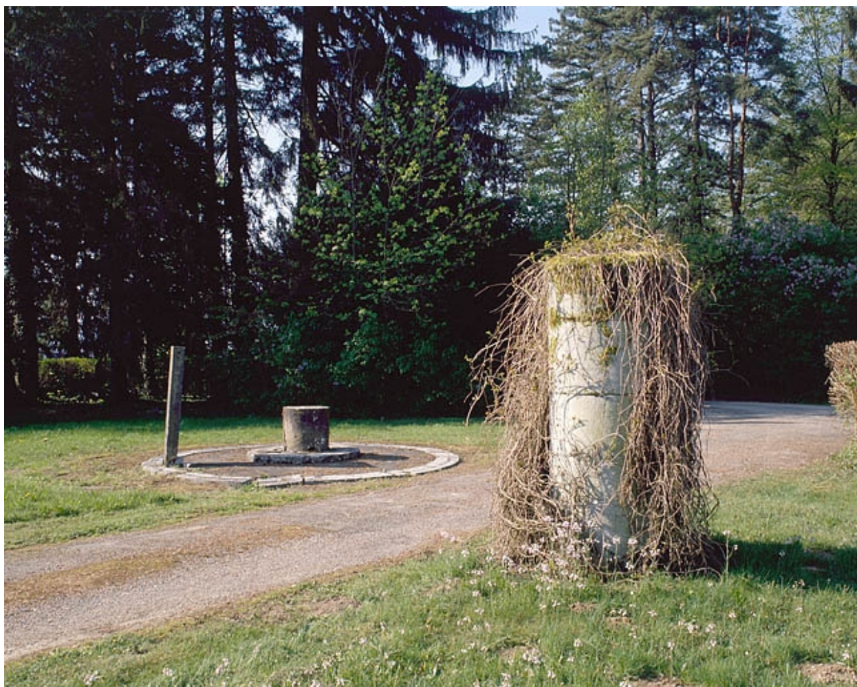
Vue d'ensemble des vestiges de la seconde coupole de la lunette. L'instrument reposait sur le pilier central ; les autres piliers étaient destinés à la mire et à l'horloge.
