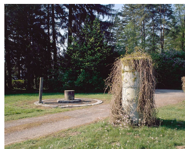
Vue d'ensemble des vestiges de la seconde coupole de la lunette. L'instrument reposait sur le pilier central ; les autres piliers étaient destinés à la mire et à l'horloge. Phot. Jérôme Mongreville IVR43_20022501128XA
