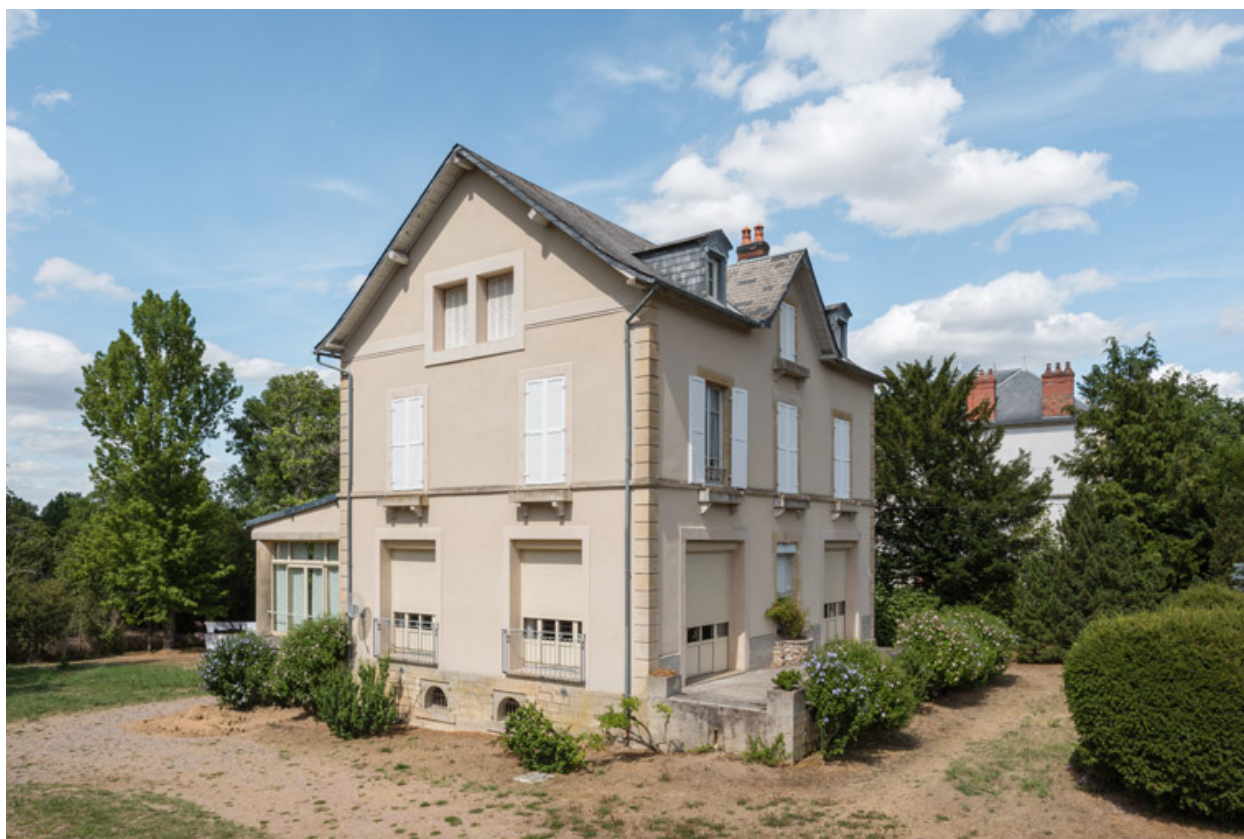
Vue depuis le sud.
