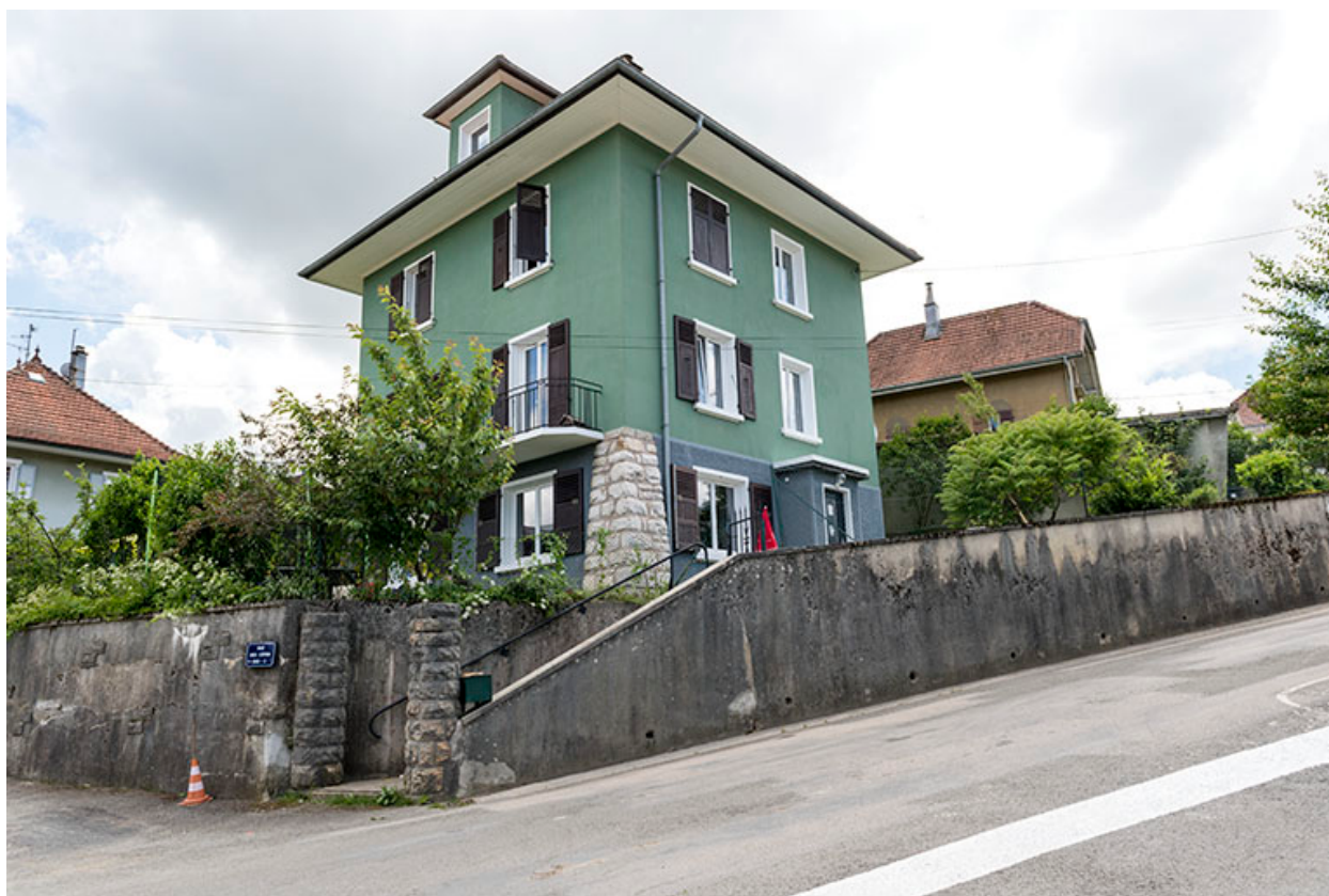
Façades antérieure et latérale droite.
