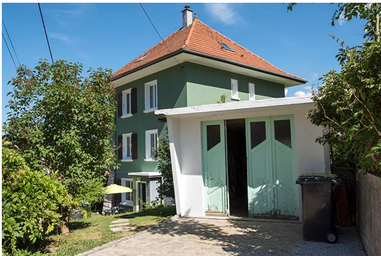
Garage et façade latérale droite.
