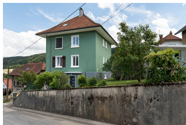
Façade latérale droite, de trois quarts. Phot. Sonia Dourlot
