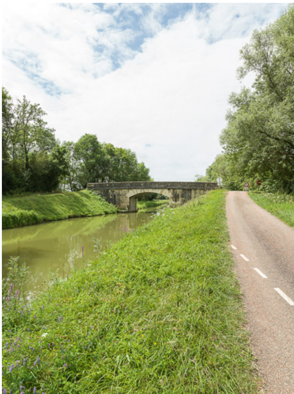
Vue d'ensemble du pont et du site.
