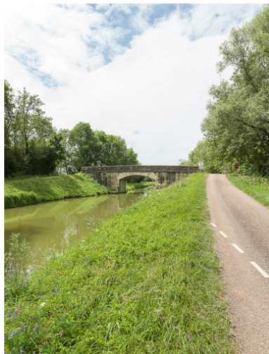
Vue d'ensemble du pont et du site. Phot. Pierre-Marie Barbe-Richaud IVR26_20175800191NUC2A
