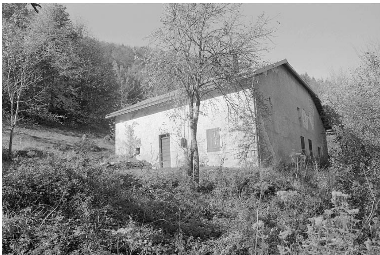
Façade antérieure et face est.
