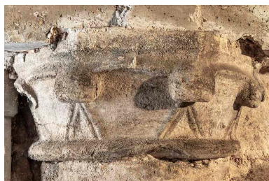
Sous-sol : chapiteau à crochets stylisés (nord). Phot. Jérôme Mongreville IVR43_20243900951NUC4A
