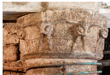
Sous-sol : chapiteau à crochets stylisés (sud). Phot. Jérôme Mongreville IVR43_20243900950NUC4A
