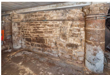
Sous-sol : colonnes et chapiteaux. Phot. Jérôme Mongreville IVR43_20243900949NUC4A
