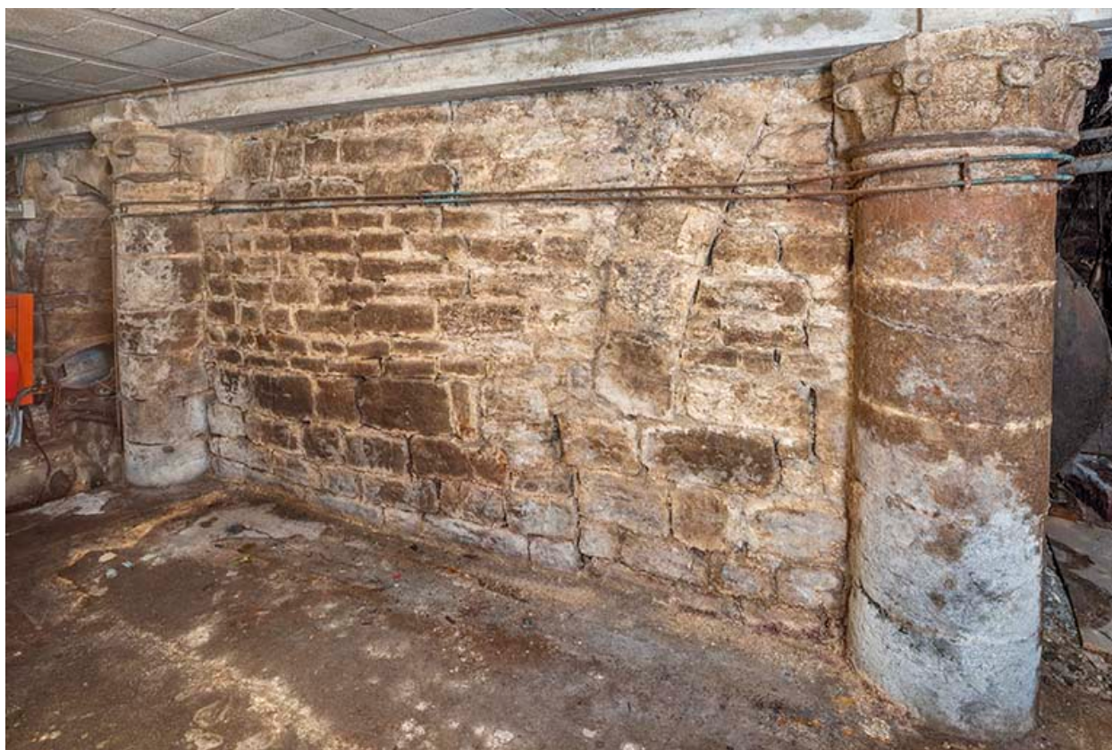
Sous-sol : colonnes et chapiteaux.
